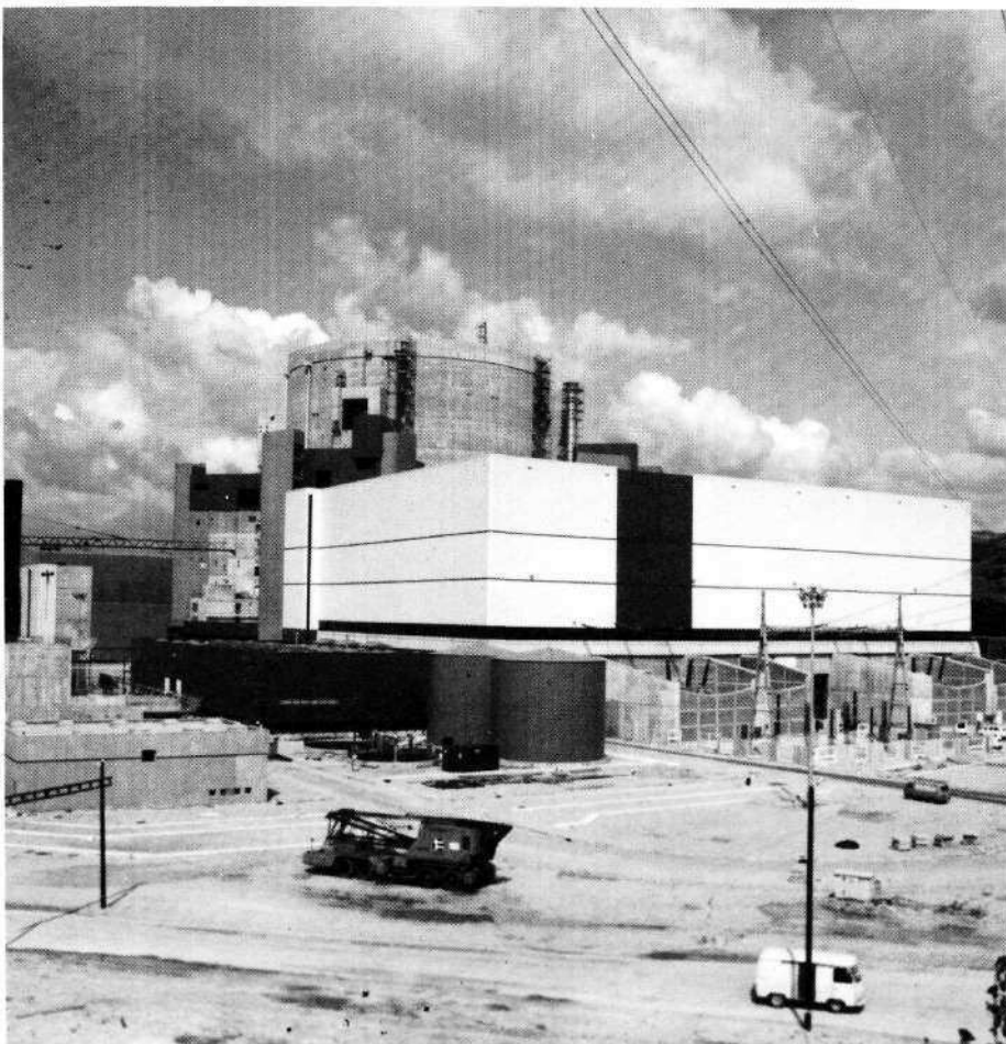
Vue générale de la centrale.
