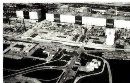
Centrale de Gravelines.
