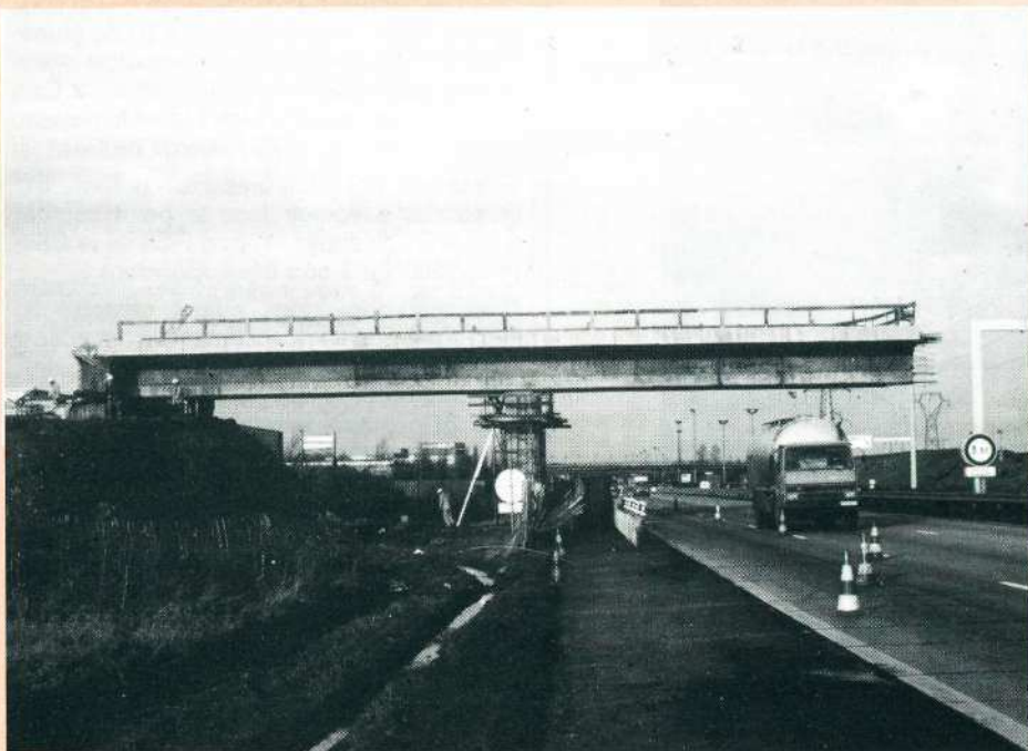
Vue du tablier en cours de poussage, la voie de droite de l'Autoroute étant alors neutralisée.
