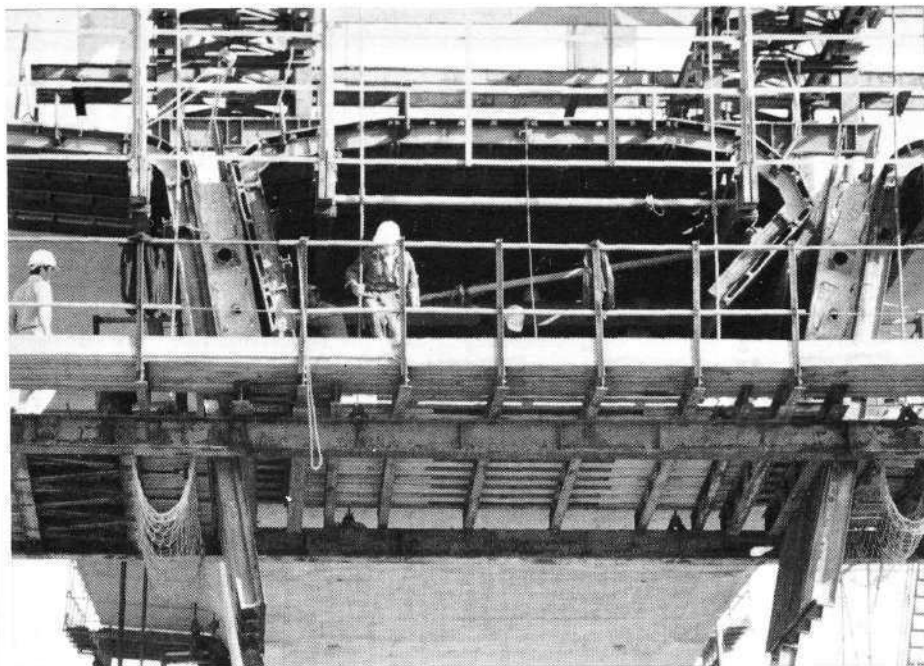
Le demi-pont rive droite en avril 80, et la Centrale à béton.
