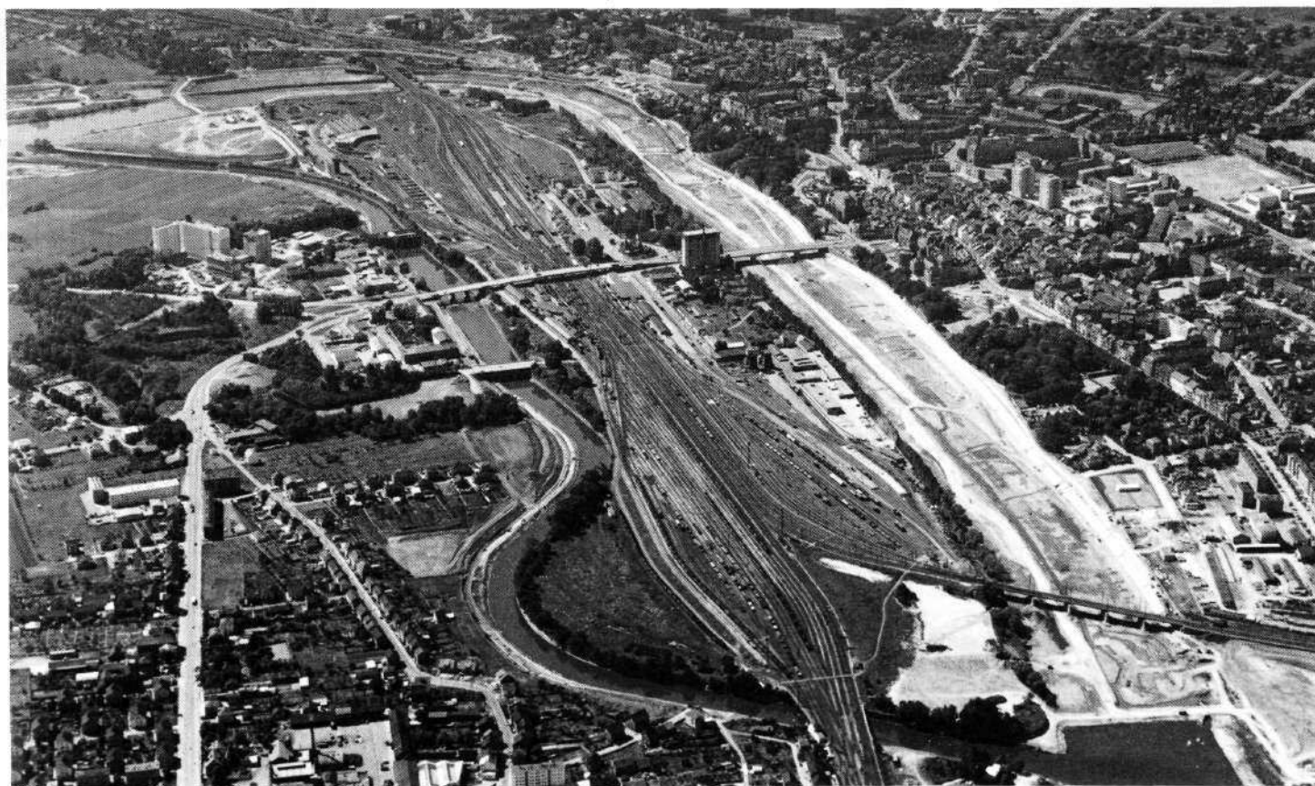
Une opération audacieuse : détournement de la Moselle à Thionville pour le creusement du chenal (été 1962).
