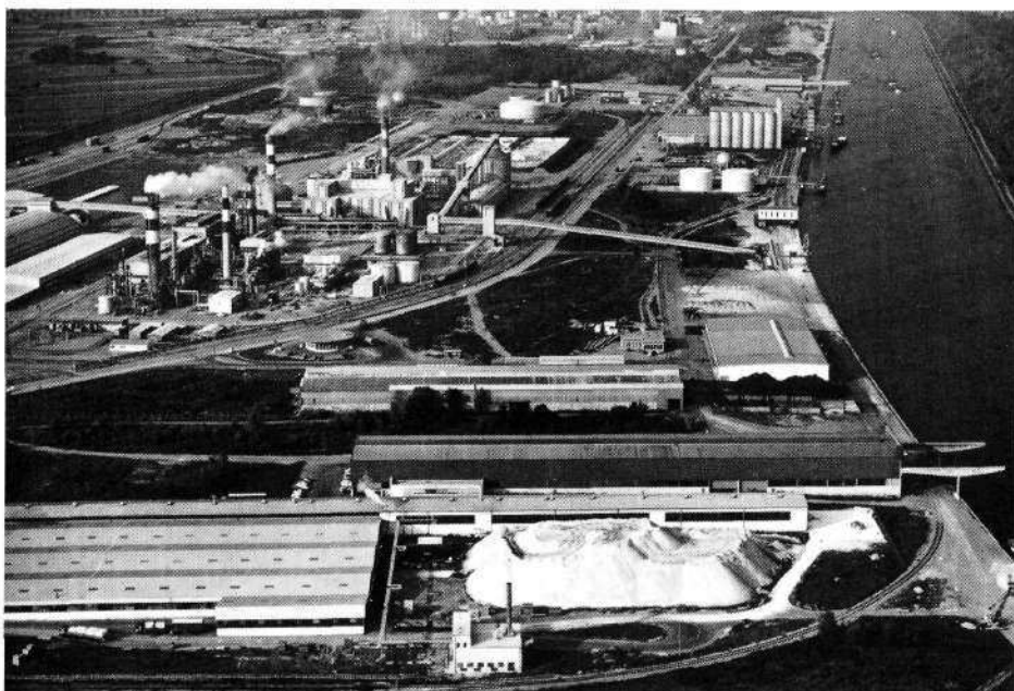
Zone portuaire et industrielle de Mulhouse. OTTMARSHEIM. "Documents du Port Autonome de Strasbourg".
