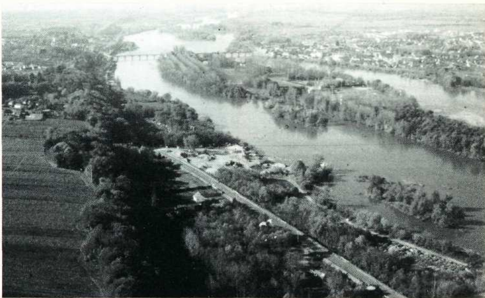
Le site du nouveau franchissement de la Loire.
