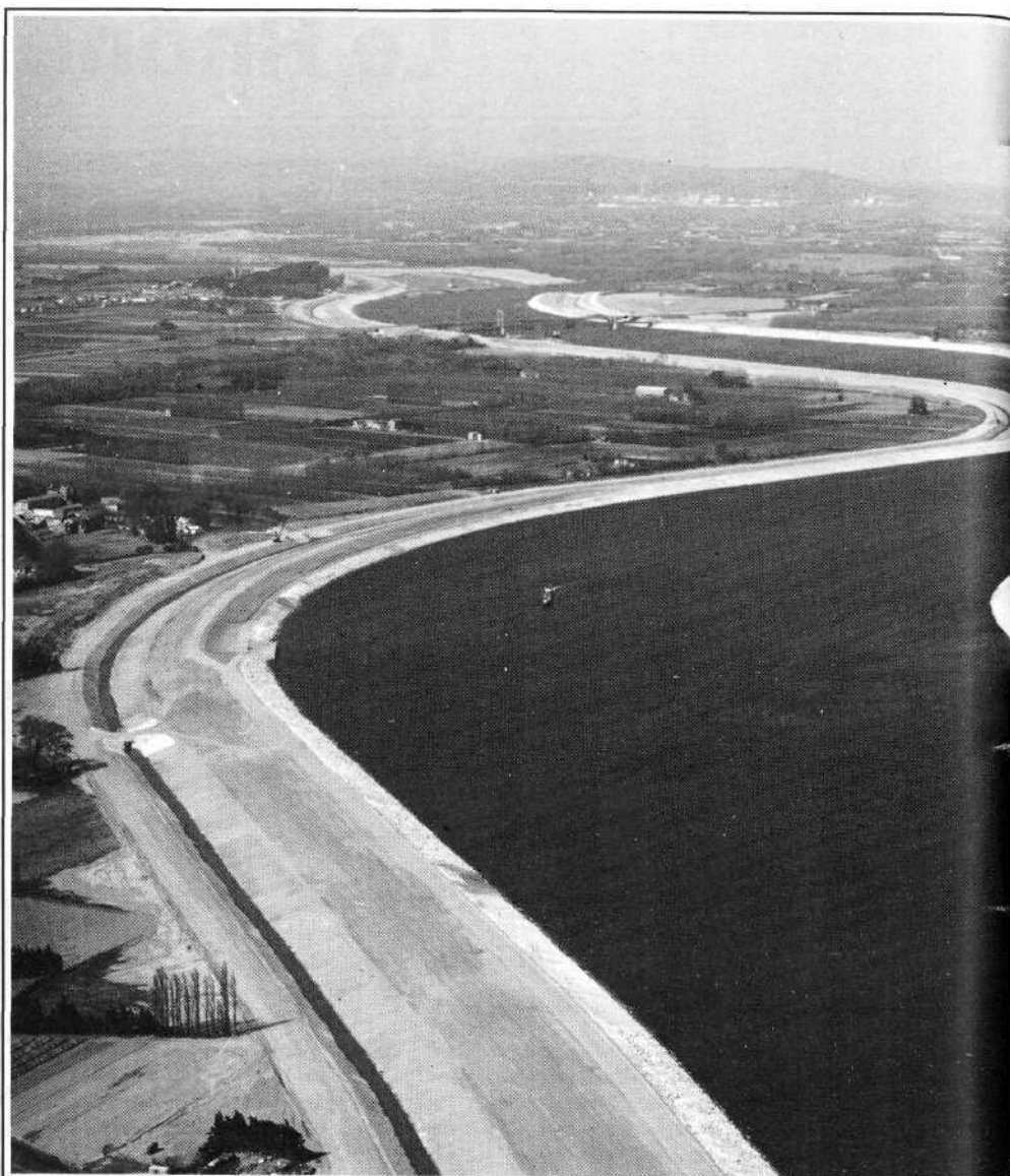
Aménagement de Beau Chastel. Vue vers l'aval prise depuis le barrage de Charmes
