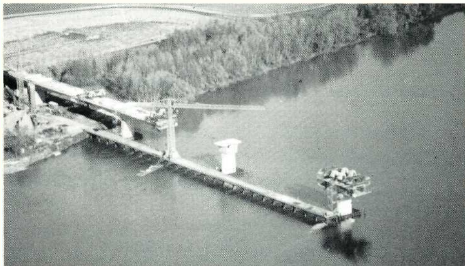
L'ouvrage en construction, vu du coteau Sud.
