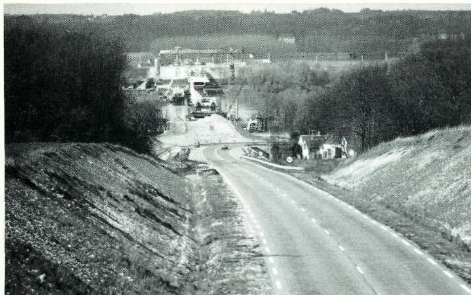
La desserte du chantier était assurée par une estacade.
