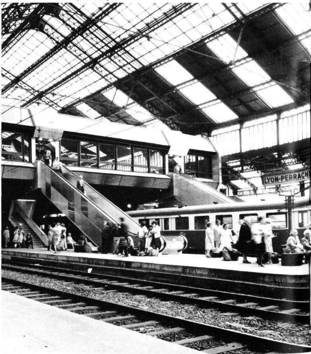
Lyon-Perrache. Structure pour le départ.
