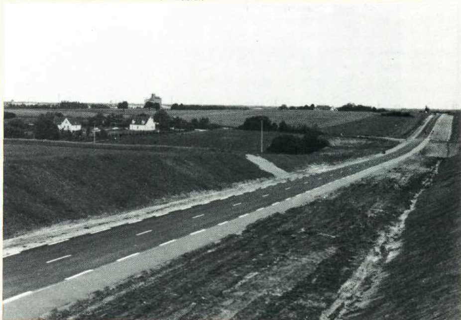
Section courante dans une zone en déblai.
