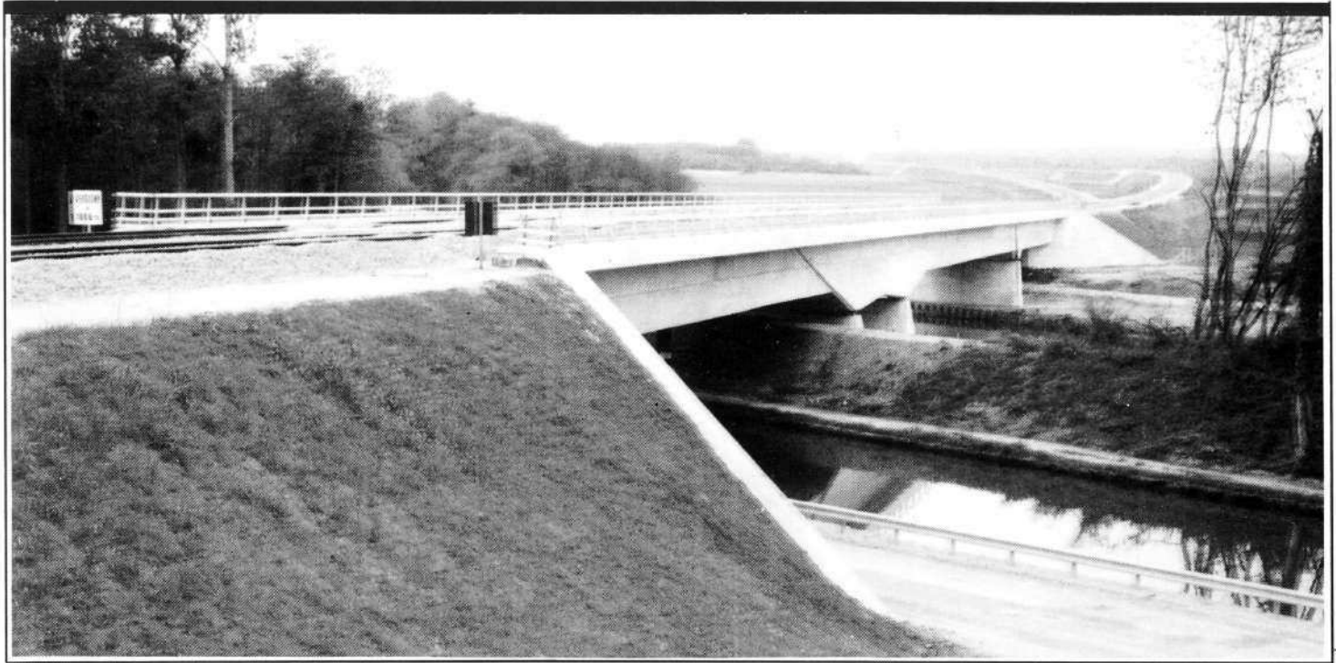
Pont sur le canal de Bourgogne et l'Armaçon (figure n° 1).
