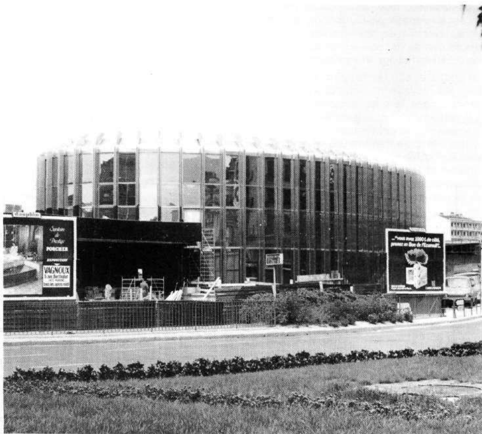
Annecy. Corps Central en cours de travaux.
