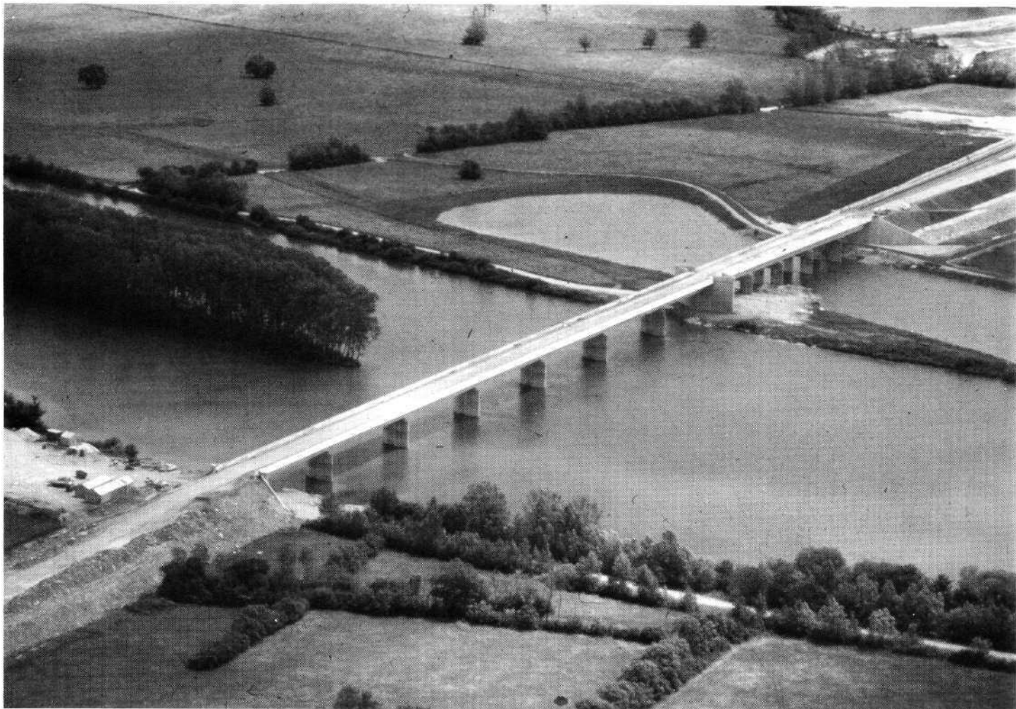
T.G.V. Pont sur la Saône à Macon, poussé sur 340 mètres.
