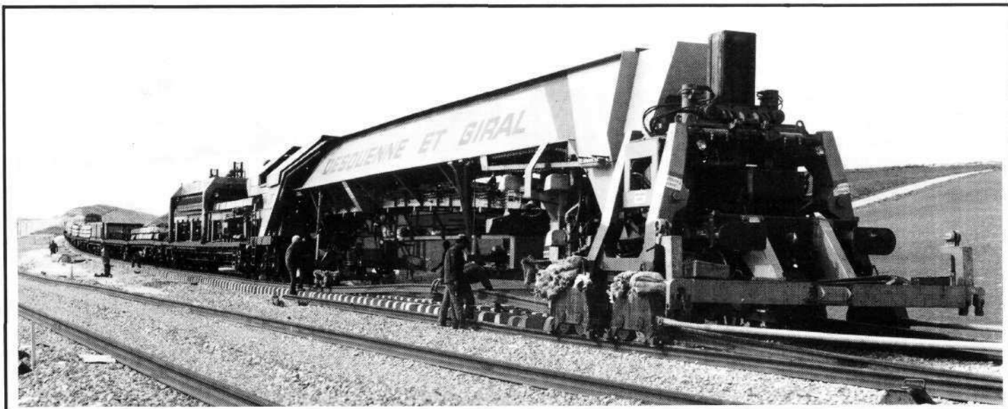
Le train de pose Desquennes et Giral.
