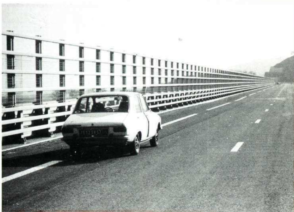
La barrière spéciale du viaduc
