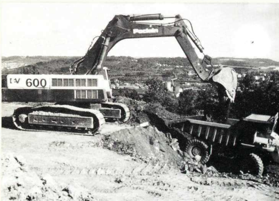
Les terrassements à l'aide de la Poclairn 600
