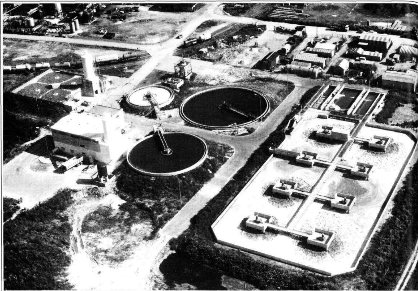
Au premier plan, le bassin d'oxydation et de nitrification avec ses 8 turbines, et le bassin de tête de dénitrification en anoxie traitant un flux mixte, effluent nitrifié, effluent brut. (photo DEGREMONT)
