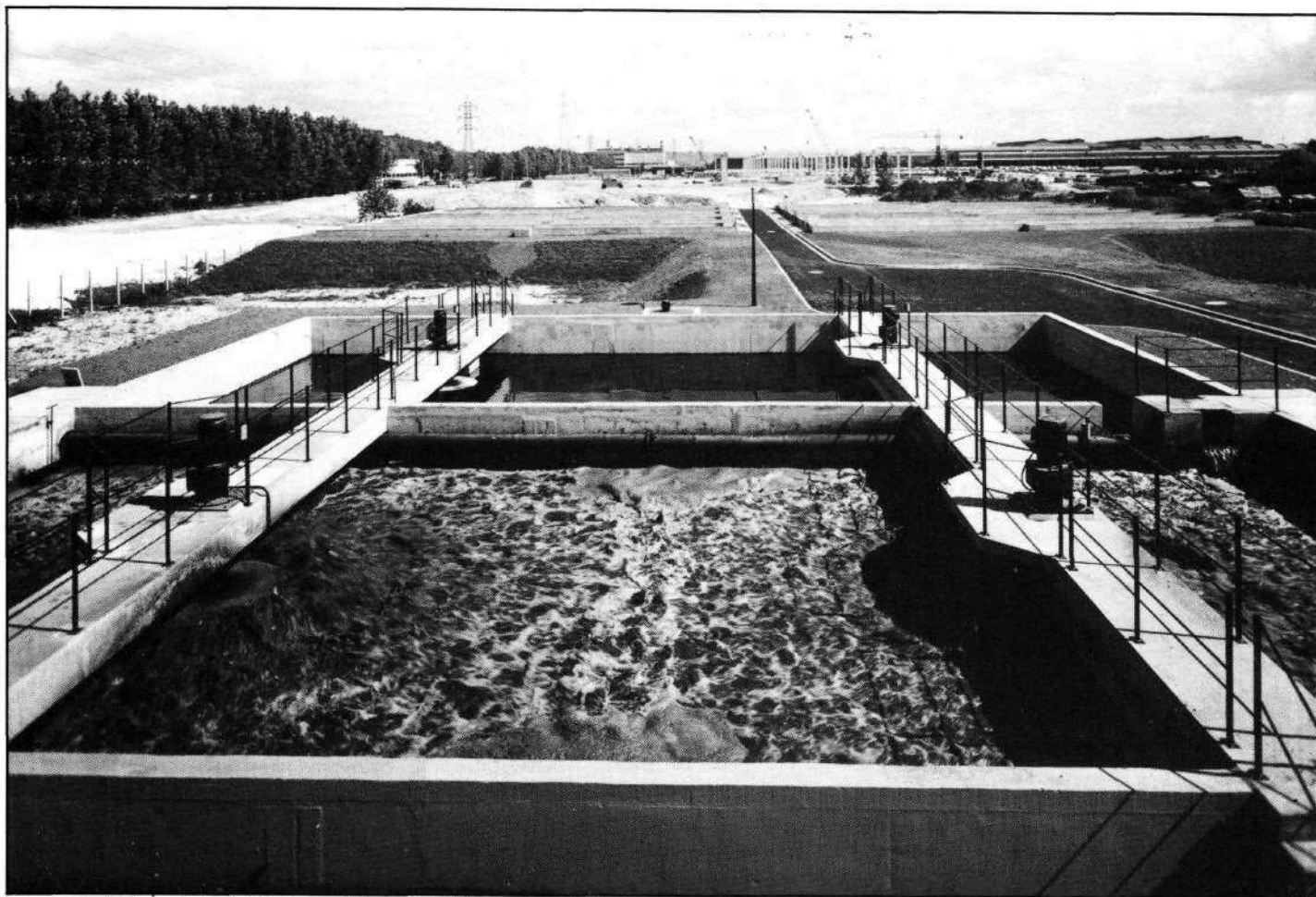
Bassins d'aération et de stabilisation de la station d'épuration d'Aubergenville (78) 15 000 habitants (en arrière-plan les lits de séchage) Photo René-Jacques — Document Omnium d'Assainissement.
