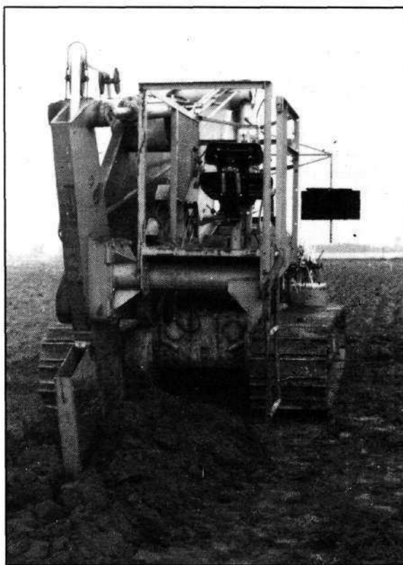
Mise en place d'un drain par Trancheuse-poseuse.
