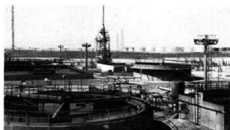
Traitement physicochimique et biologique avec incinération des boues. Raffinerie ESSO - Fos-sur-Mer.
