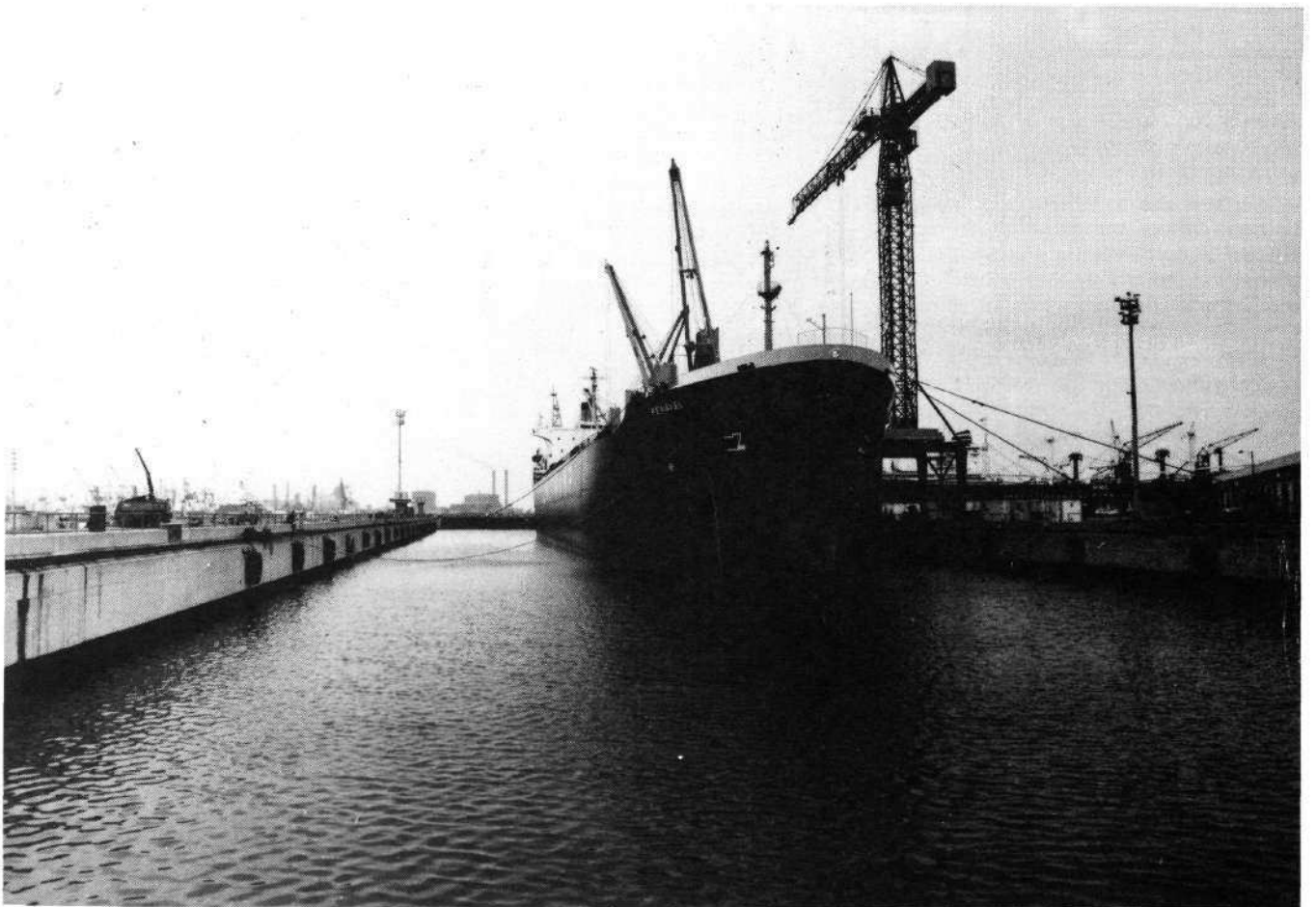
Vue d'ensemble de la forme du radoub Secoter du Port de DUNKERQUE.
