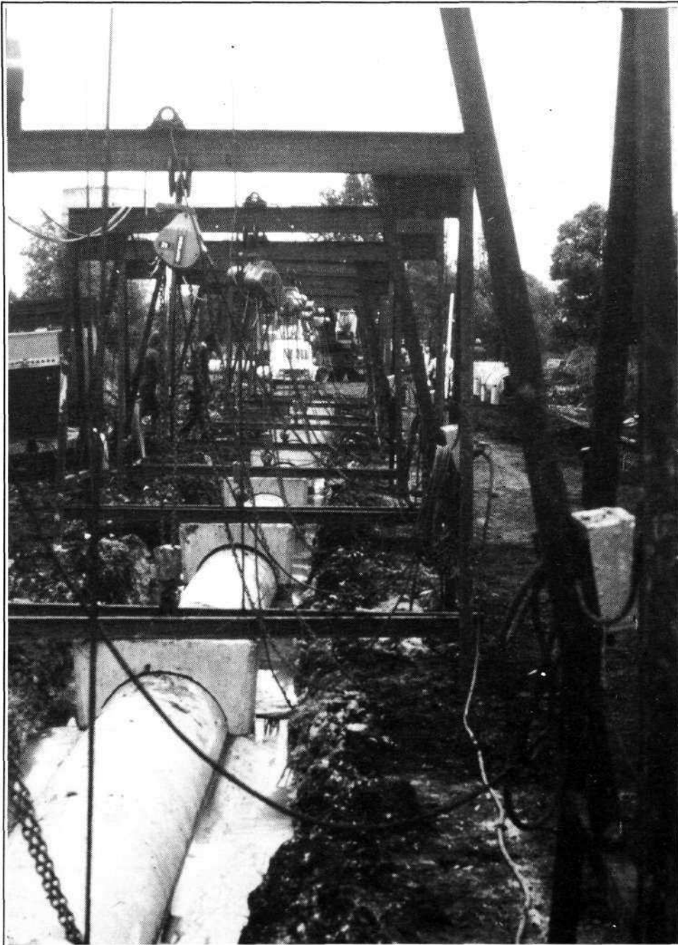
Mise en place d'un égout sous coulis.
