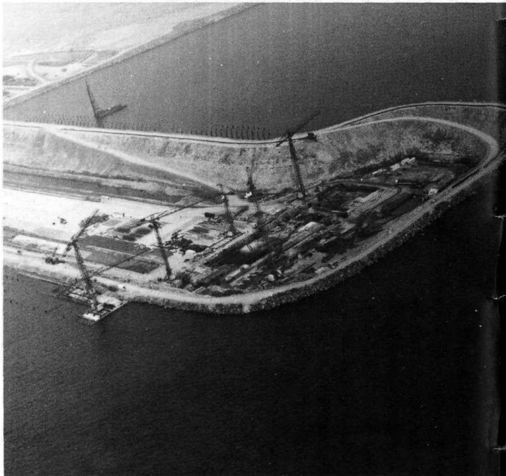
Batardeau de la forme de radoub de BREST.
