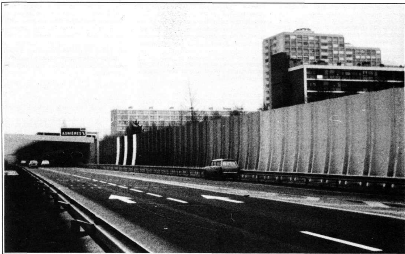
Autoroute A86 à Colombes. Écran en béton recouvert de peinture polychrome.
