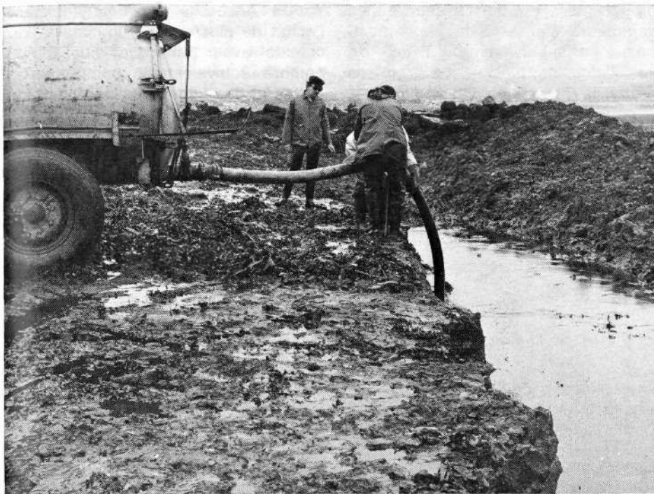
Pompage du mazout.
