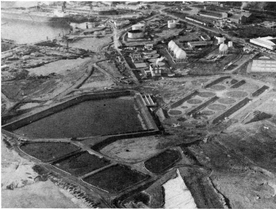
Station de dégazage du Port de Brest.
