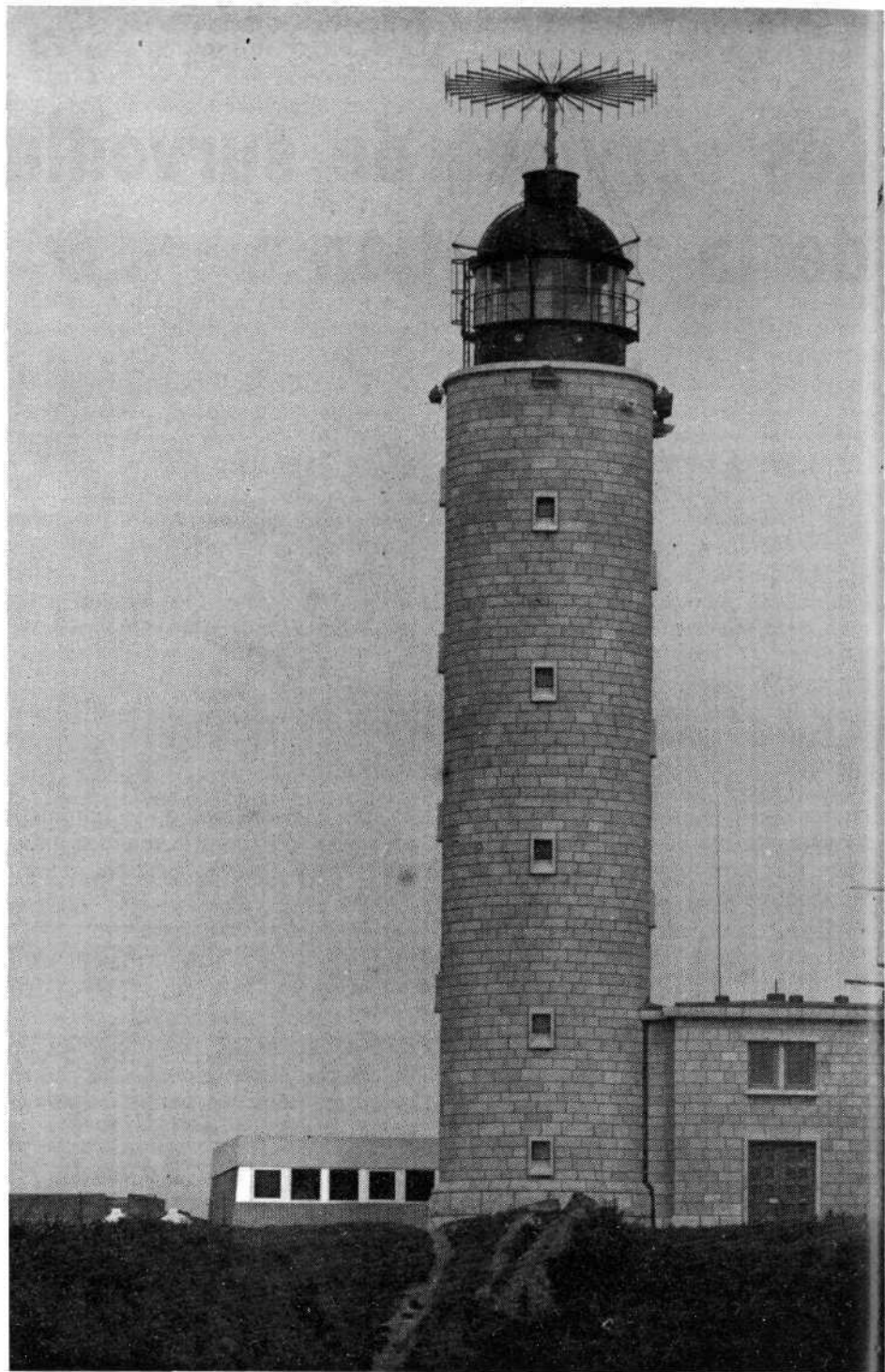
Le Centre de Gris-Nez. — Le phare surmonté du radiogoniomètre.
