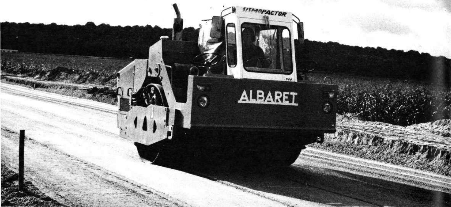
Mise à quatre voies de la nationale 330. Compactage de la couche de base. Compacteur vibrant tandem transversal. Cliché Albaret.
