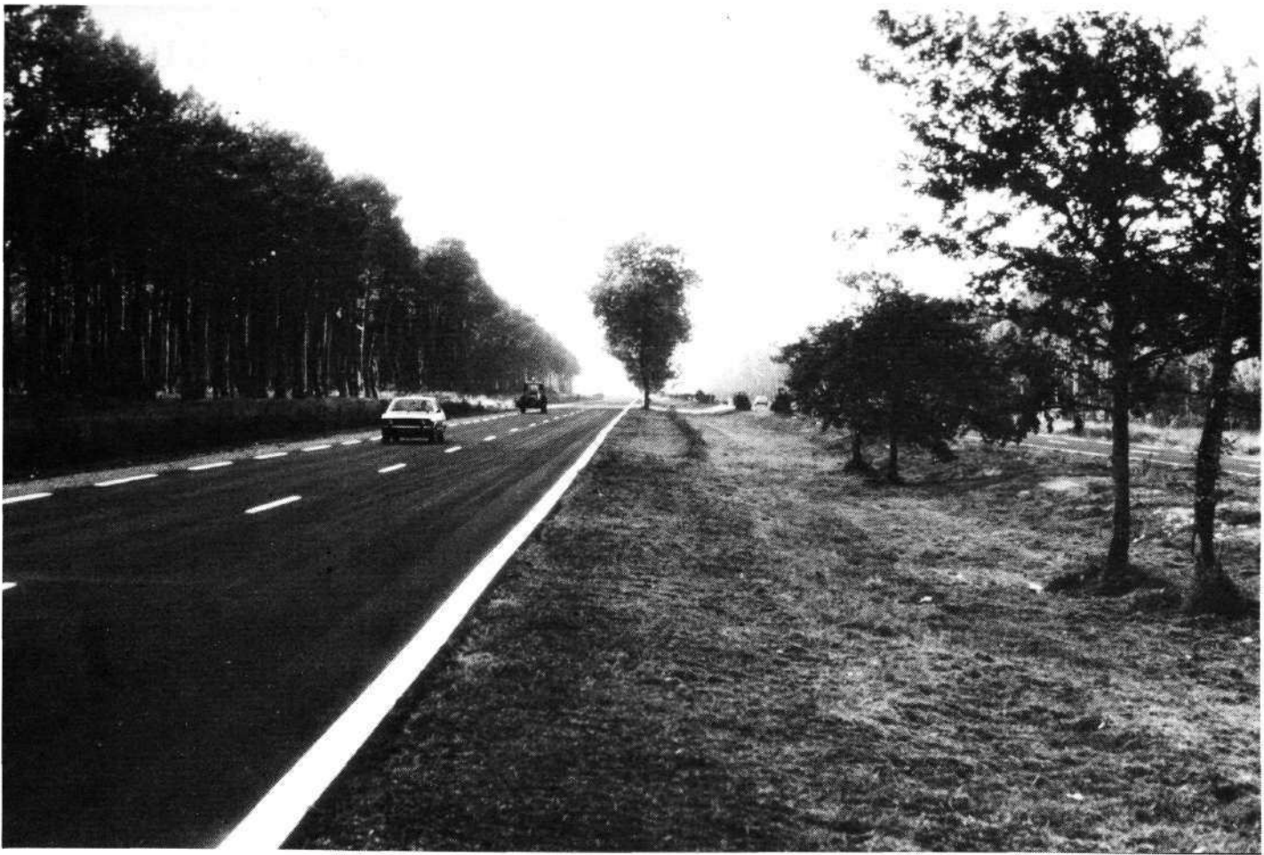
Les solutions techniques peuvent être diverses et bien adaptées au terrain. En relief difficile, les terrains centraux se doivent d'être réduits, comme sur la photo précédente ; en relief facile, et dans des terrains peu chers à l'acquisition, on peut réaliser des terre-pleins centraux plus confortables, comme le montre cette photo (RN 10 dans les Landes).
