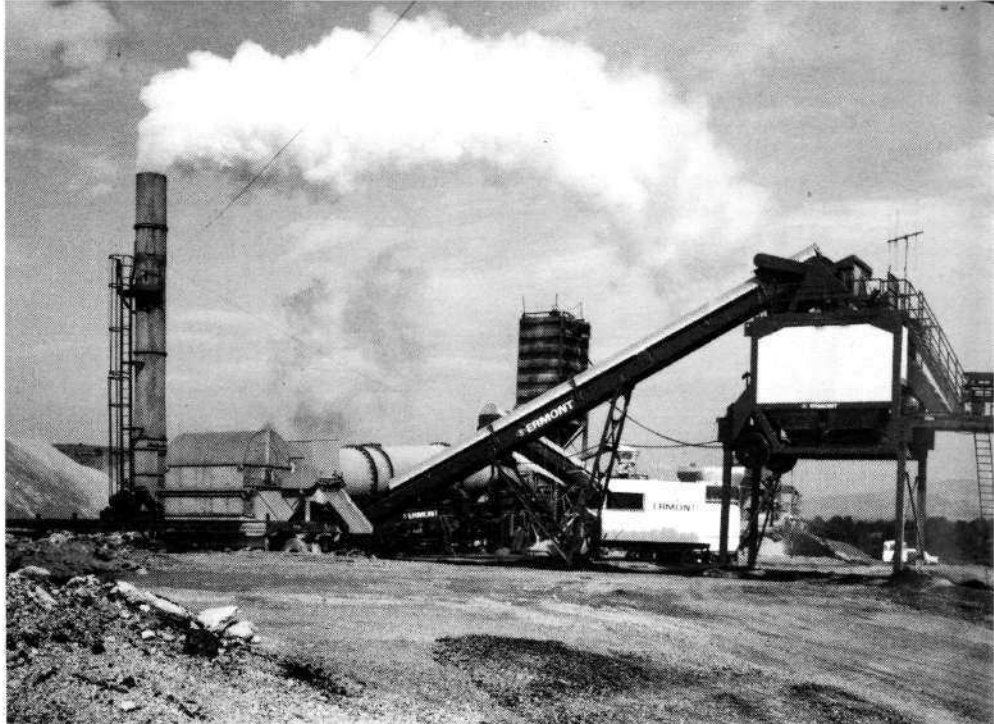
Centrale d'enrobage sécheur-malaxeur TSM. Cliché Ermont.
