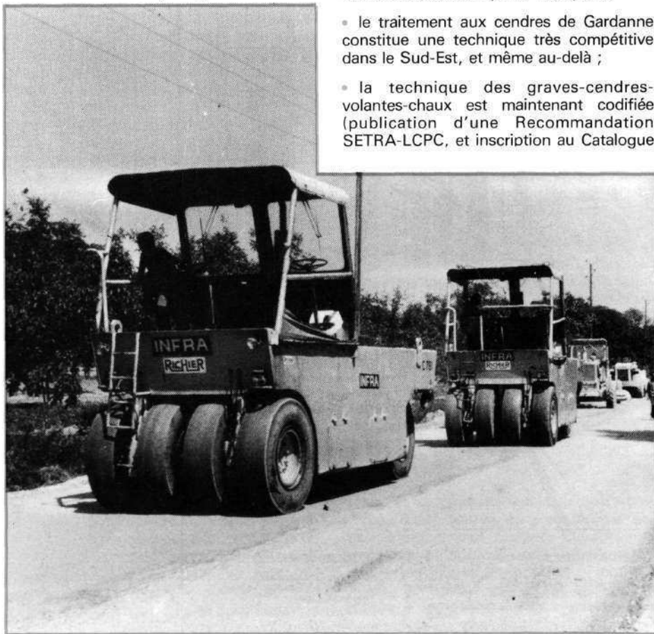
Fig.2 Renforcement sous circulation en grave-ciment retardée. Le compactage.
