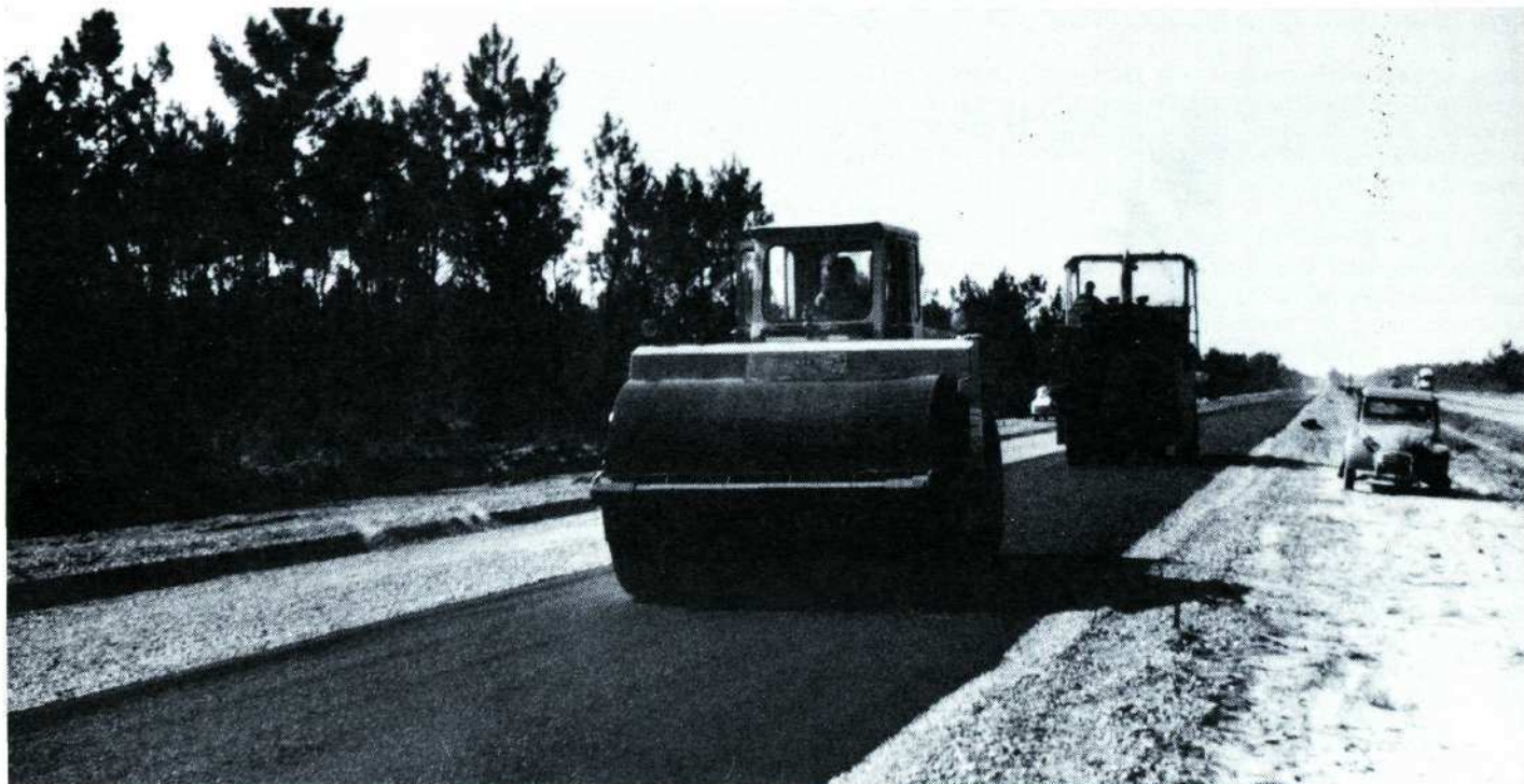
Fig.3 Compactage d'une assise en grave-bitume.
