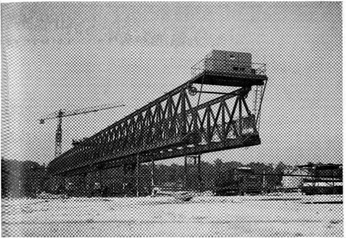
La poutre de lancement de 127 m de long construite pour le chantier de l'échangeur de St-Maurice. — L'échangeur de St-Maurice comprend près de 3 km de tablier de pont construit par voussoirs successifs préfabriqués. La plus grande travée a une portée de 117 m avec un rayon de courbure de 350 m.
