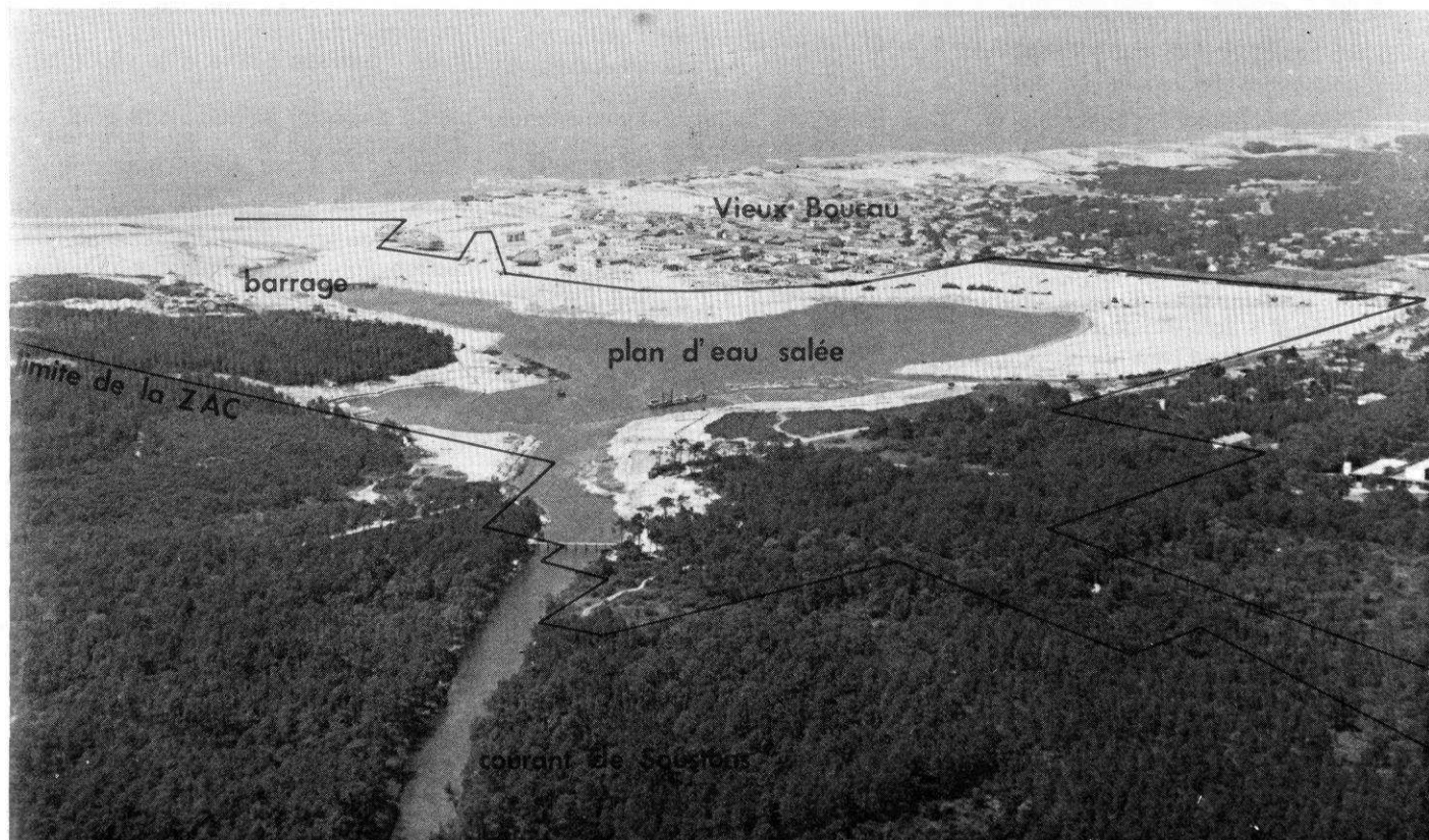
Le site de l'opération de port d'Albret : on reconnaît l'urbanisation existante de Vieux Boucau, la première tranche du plan d'eau salée avec le barrage mobile, les terrassements qui recevront les hébergements de la première ZAC.
