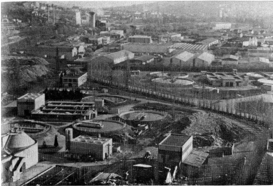
La station d'épuration de Chambéry.
