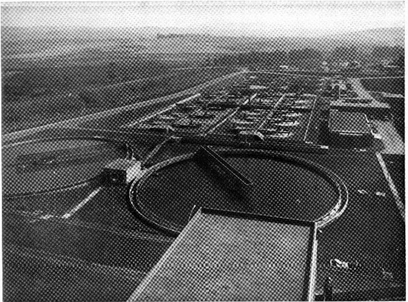
Ville de Kwa-Mashu (Afrique du Sud) 280.000 habitants. Station d'épuration biologique des eaux résiduaires avec nitrification. Traitement des boues par centrifugation et incinération sur four à soles. (Cliché Degrémont)
