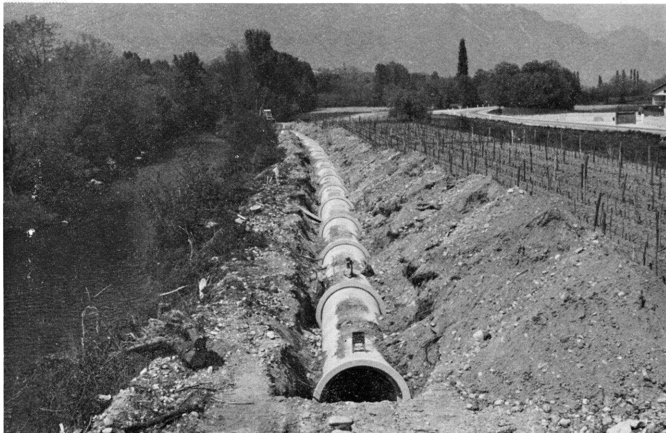
Assainissement du Lac du BOURGET. Pose au laser de la conduite de 1200 mm le long de la Leysse.
