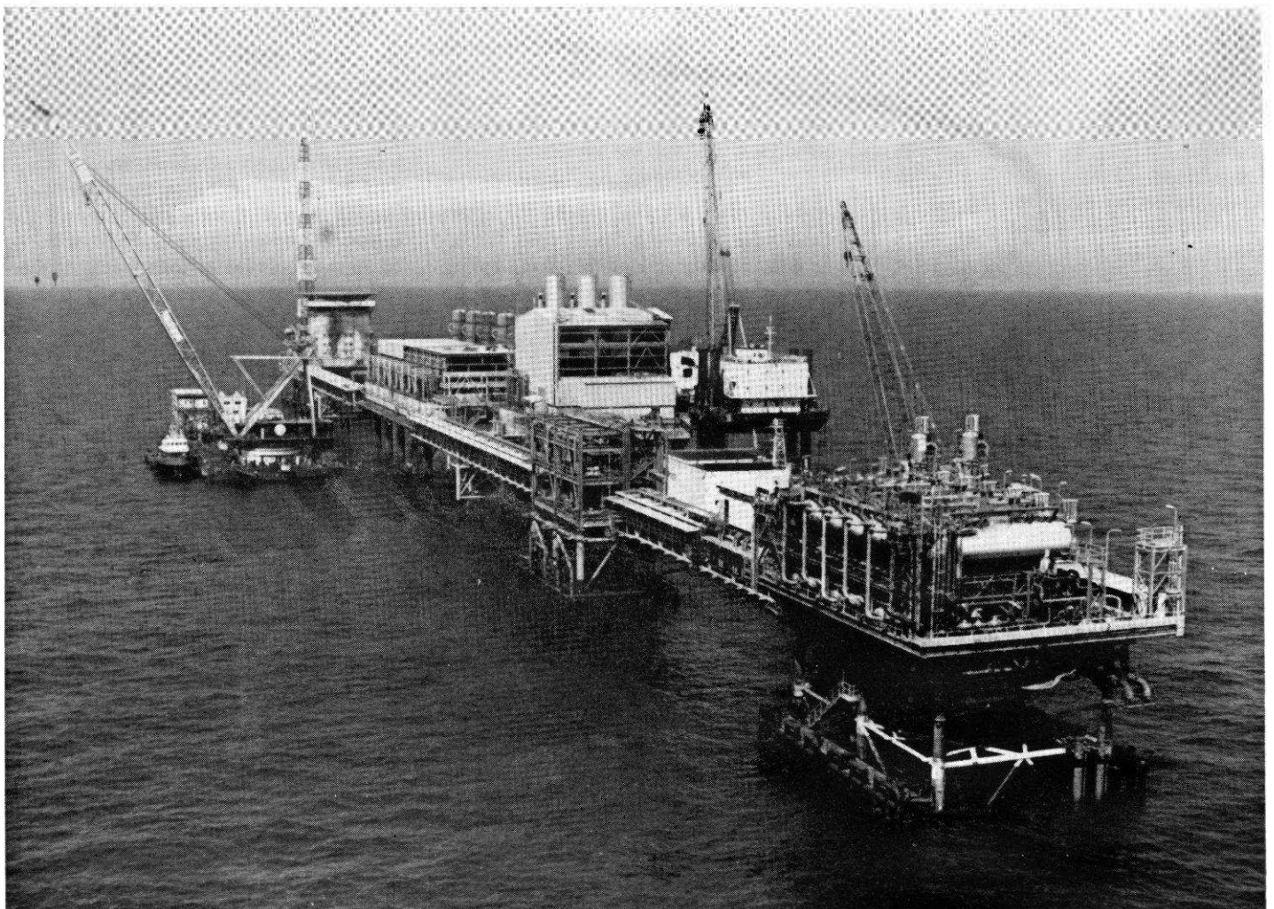
Vue générale du Super Complexe de Zakum
