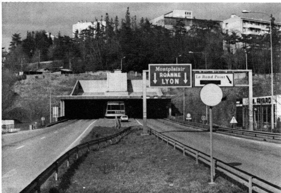
Tunnel du Rond-Point à Saint-Etienne.
