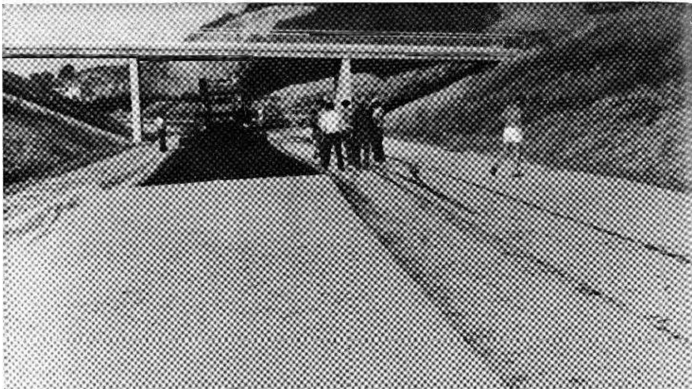
Fig. 1 : Peut-on retarder la transmission des fissures de retrait d'une grave-laitier à la couche de surface ? Essai d'interposition d'un non tissé entre le support fissuré et la couche de surface en béton bitumineux.
