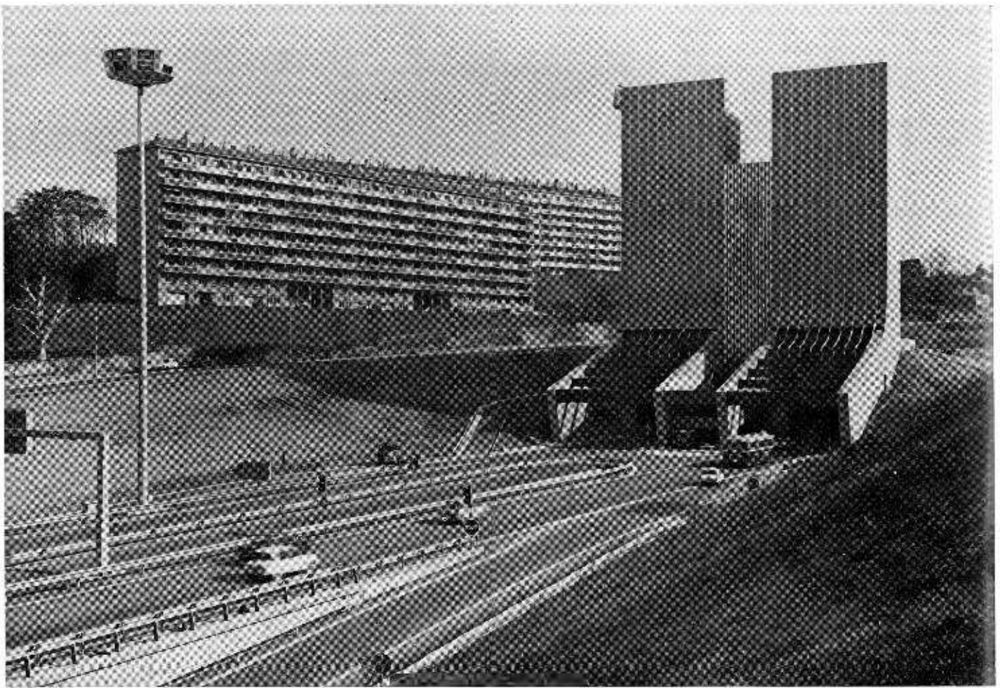
Tunnel à l'entrée de Lyon.
