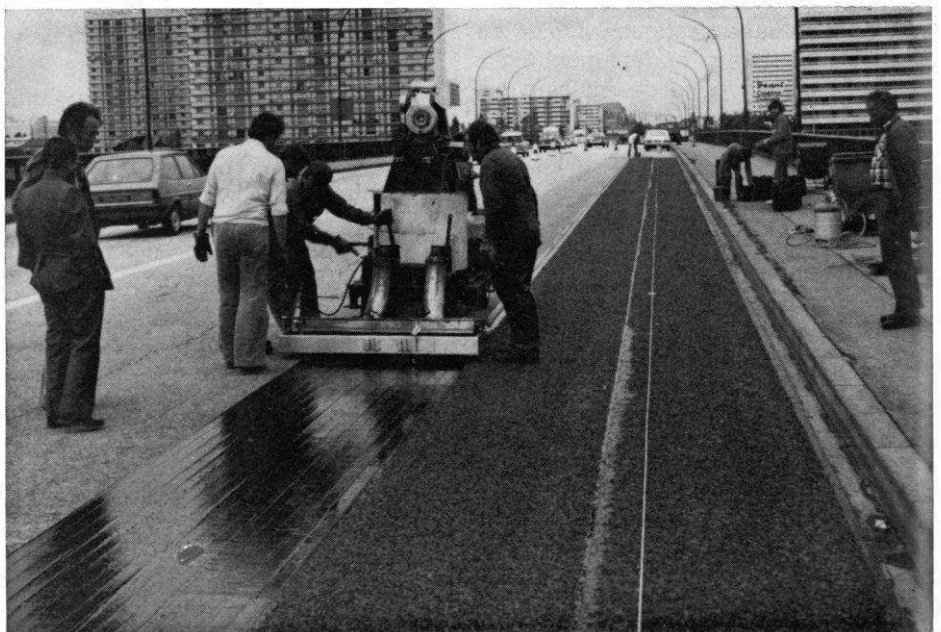
3. - Répandage de la colle bitumeuse.
