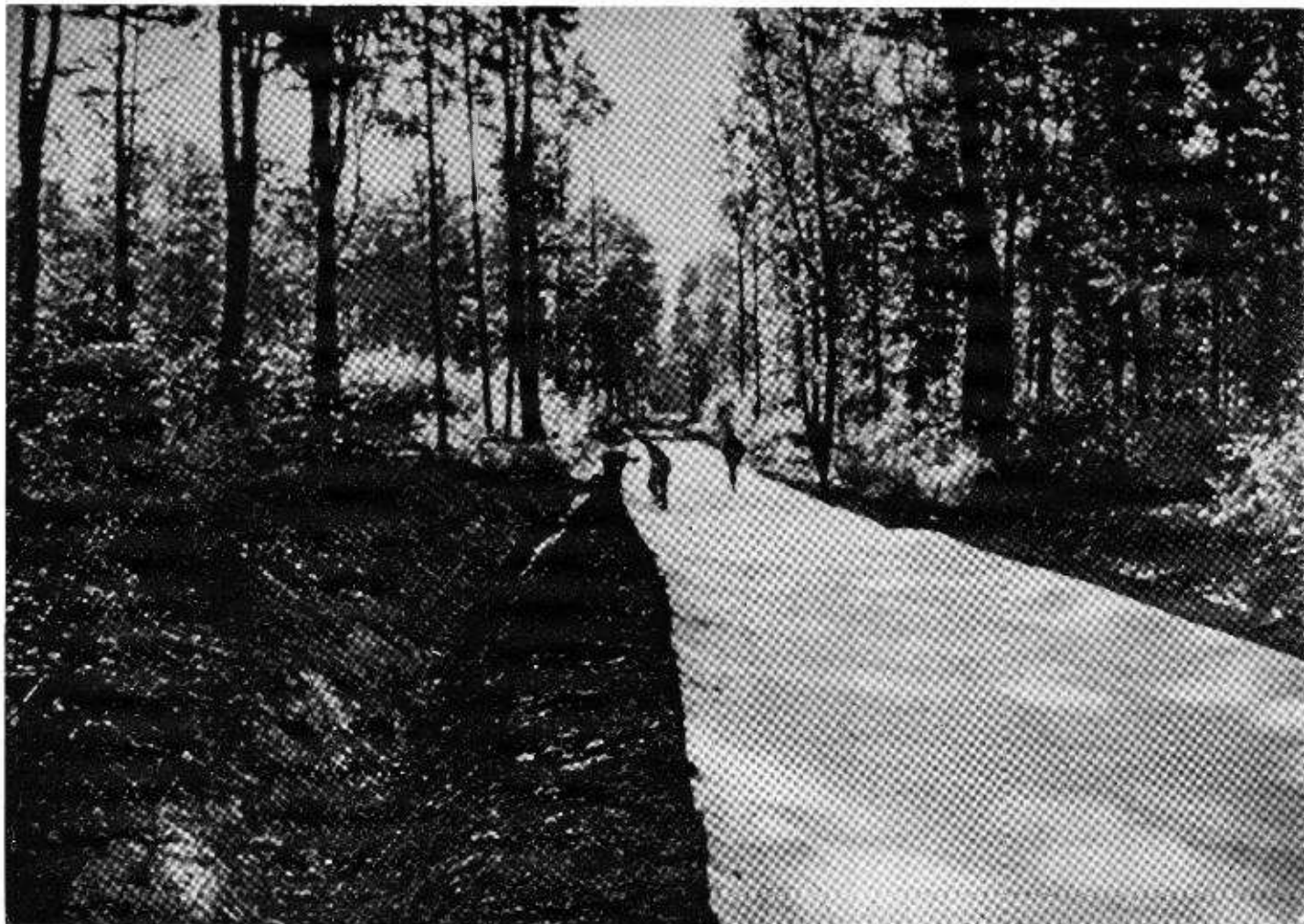
Réalisation d'une route forestière.
