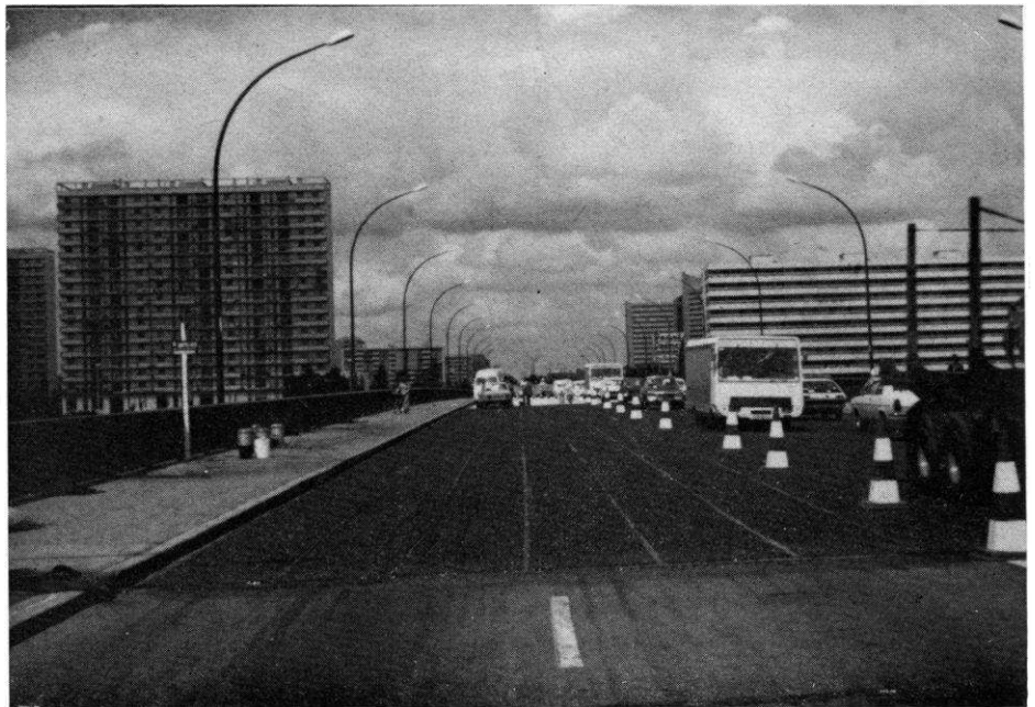
8. - 1 200 m 2 d'EP4 sur un ouvrage en béton à couche de roulement fissurée.
