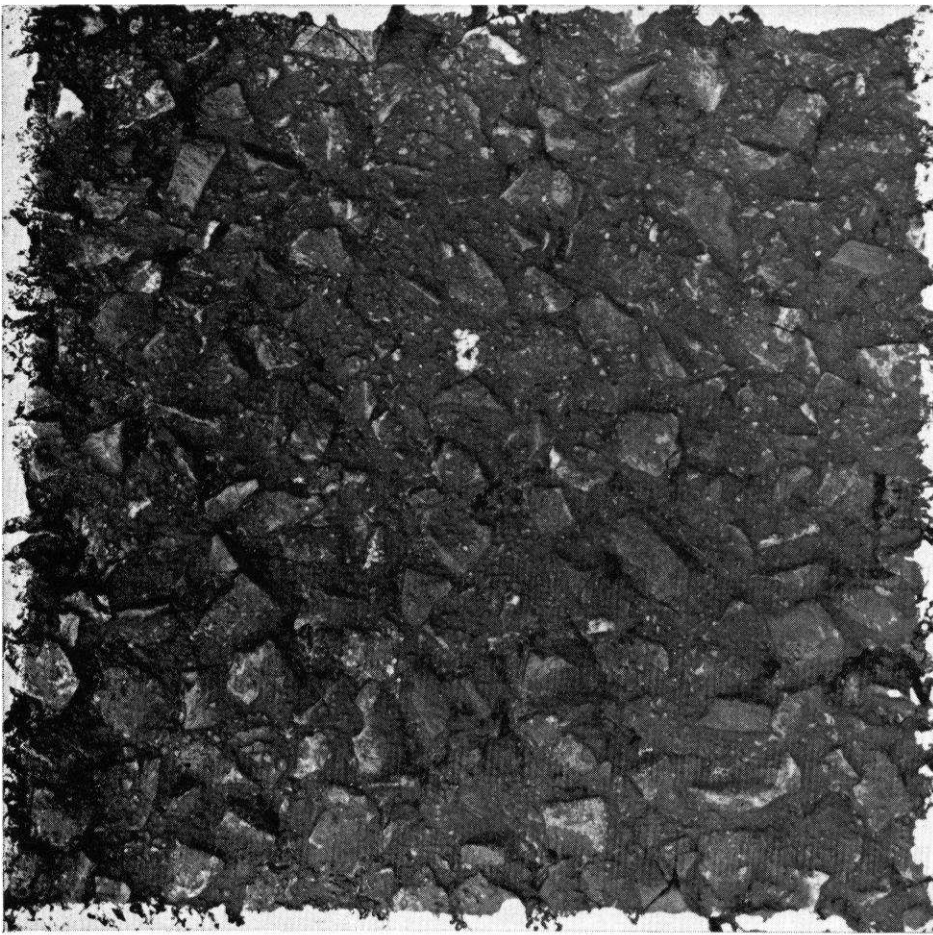
Fig. 2 : Une formule inhabituelle de béton bitumineux = matériau très discontinu pour couche d'entretien en faible épaisseur. On distingue nettement l'effet de la discontinuité (suppression des gravillons intermédiaires 2/10 dans un 0/14). La macrorugosité est excellente.
