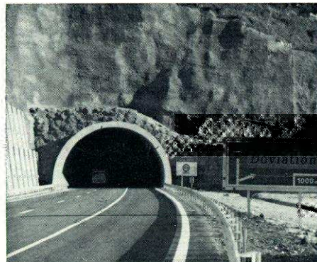
A. 8. Tunnel de la Beaume.
