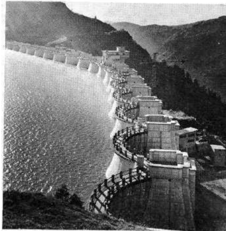
Barrage de la Girotte
