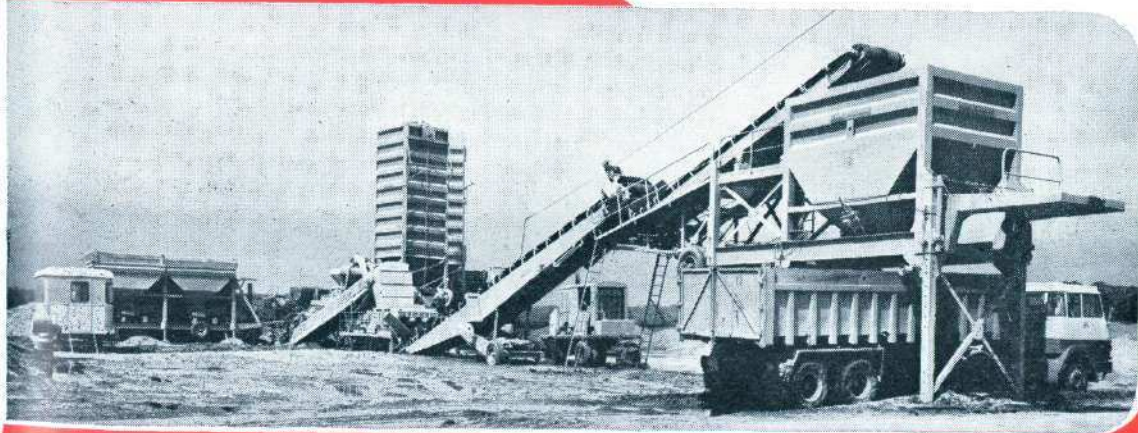
Centrale mobile 1000 tonnes/heure
