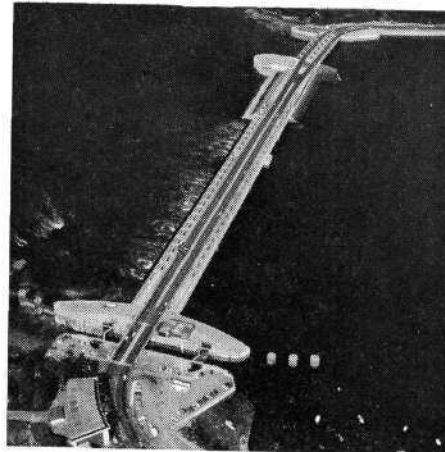
Usine marémotrice de la Rance
