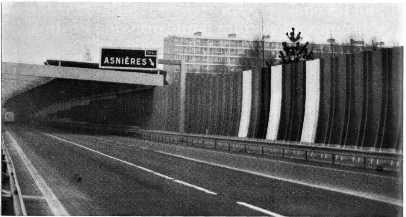
Le mur antibruit, sur le périphérique.
