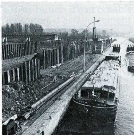
Ecluse de Verberie sur l'Oise.
