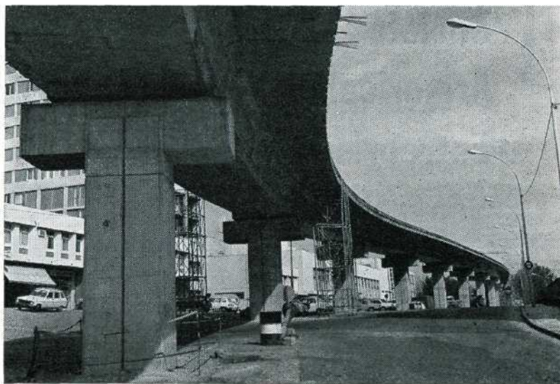
Méto de Marseille (en participation). Viaduc de la Rose (exécution Moinon).
