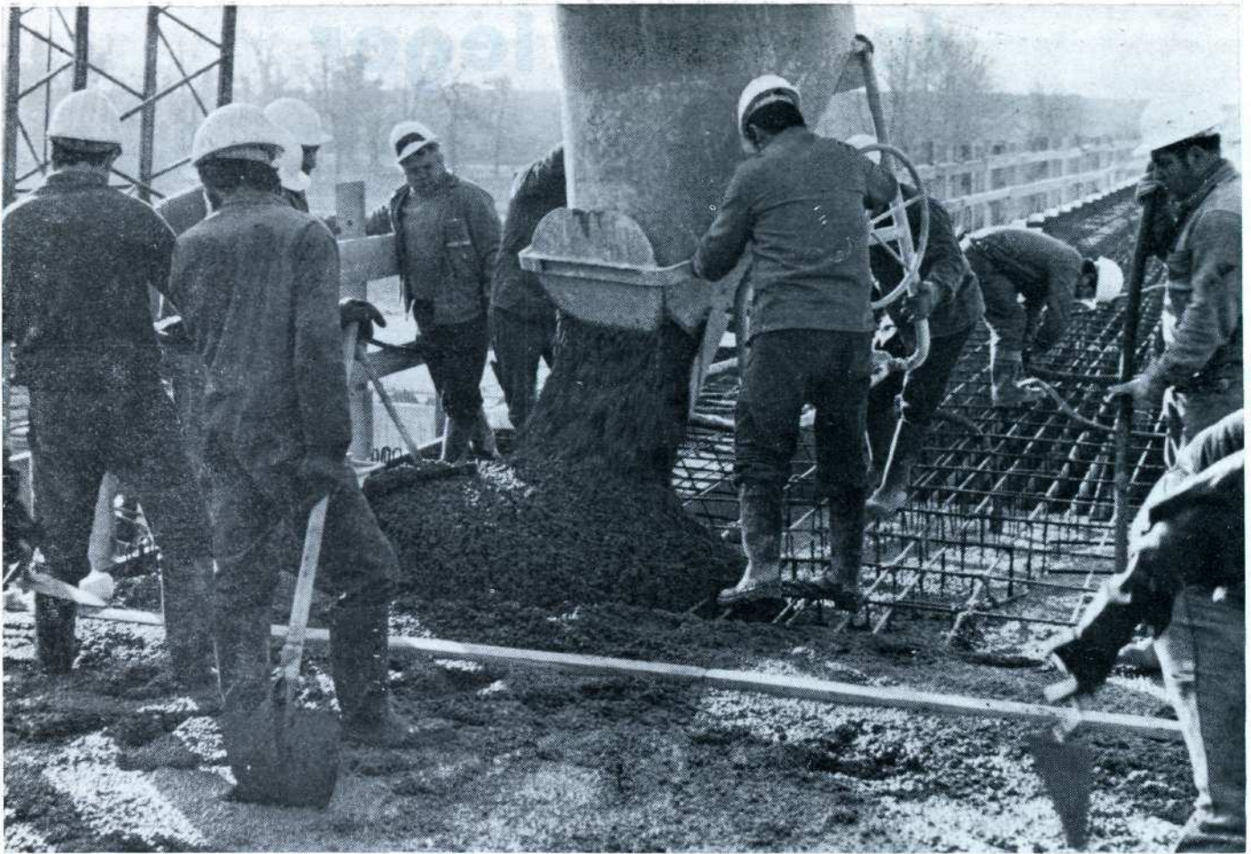
Passerelle du Tremblaye. Mise en place du béton léger.
