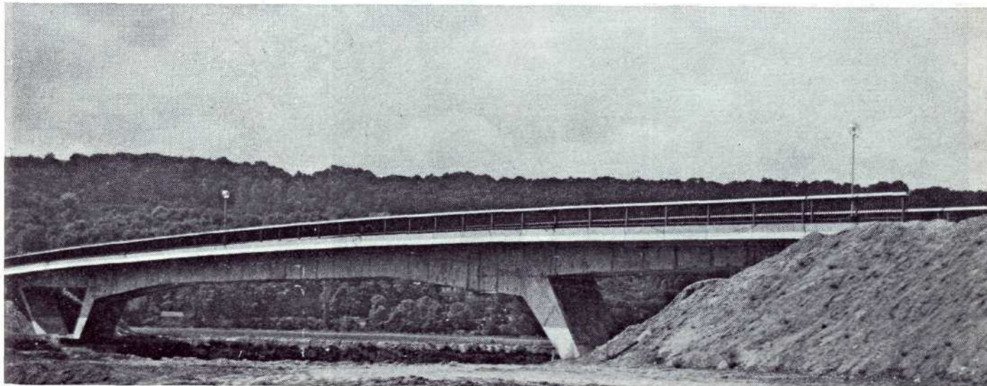
Pont de Bruyère-sur-Oise.
