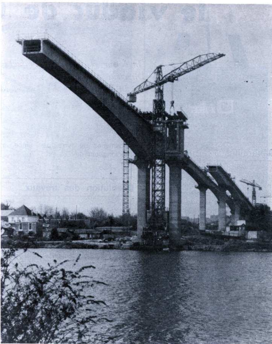
Grue. Tour affectée au chantier de pose.
