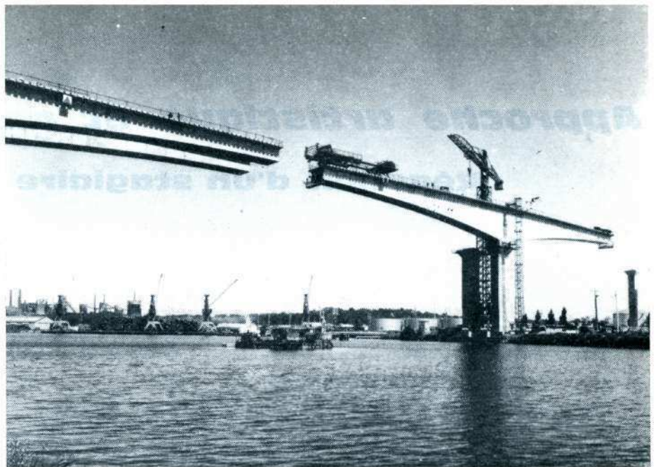
Vue d'ensemble du 3 e fléau de 156 m.
