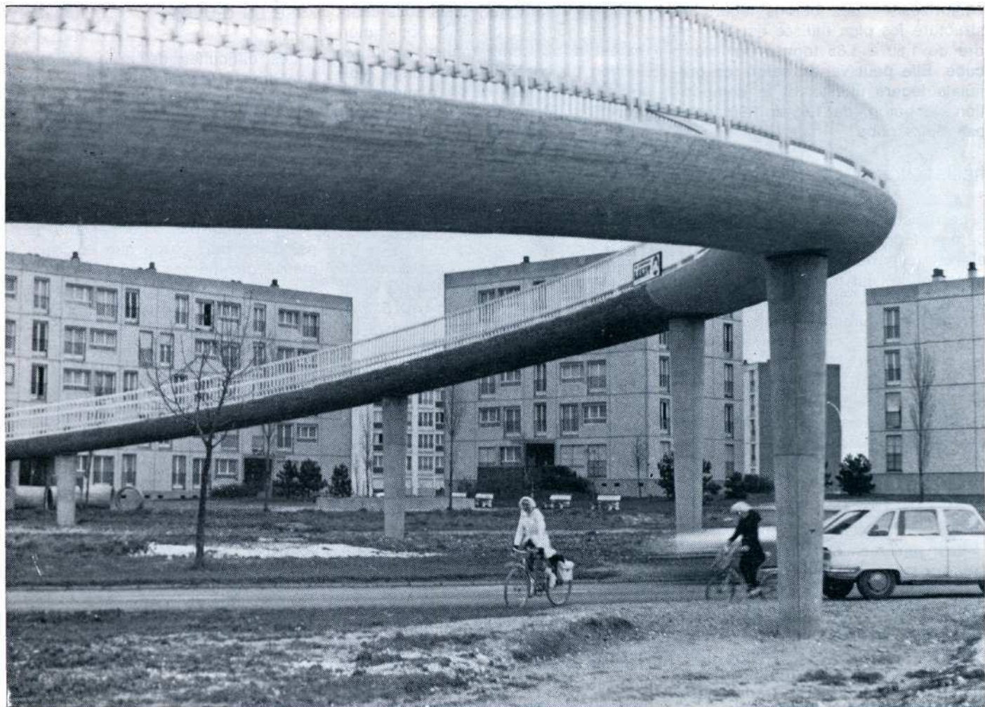
Une des deux passerelles d'Amiens.
