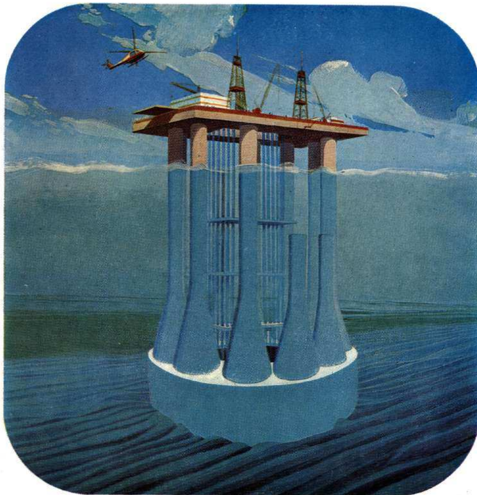
Modèle type « Mer du Nord » mis au point par BOUYGUES pour l'exploitation et le stockage des produits pétroliers offshore Plateforme ROSCO
