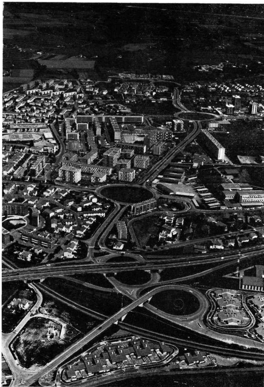
Echangeur avec la voirie primaire.
