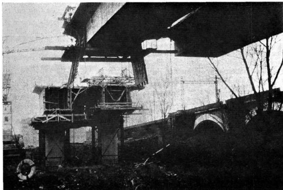
Pont de l'ONIA : les 2 travées rive gauche sont terminées. Le dernier voussoir est également terminé et l'on procède au décoffrage.
