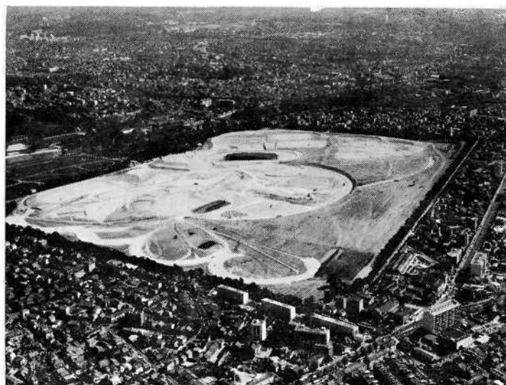
Département de PARIS - PARC DE DETENTE ET LOISIRS DU TREMBLAY Terrassements généraux : 1.000.000 m 3 M. BOURBONNAIS, Architecte en Chef
