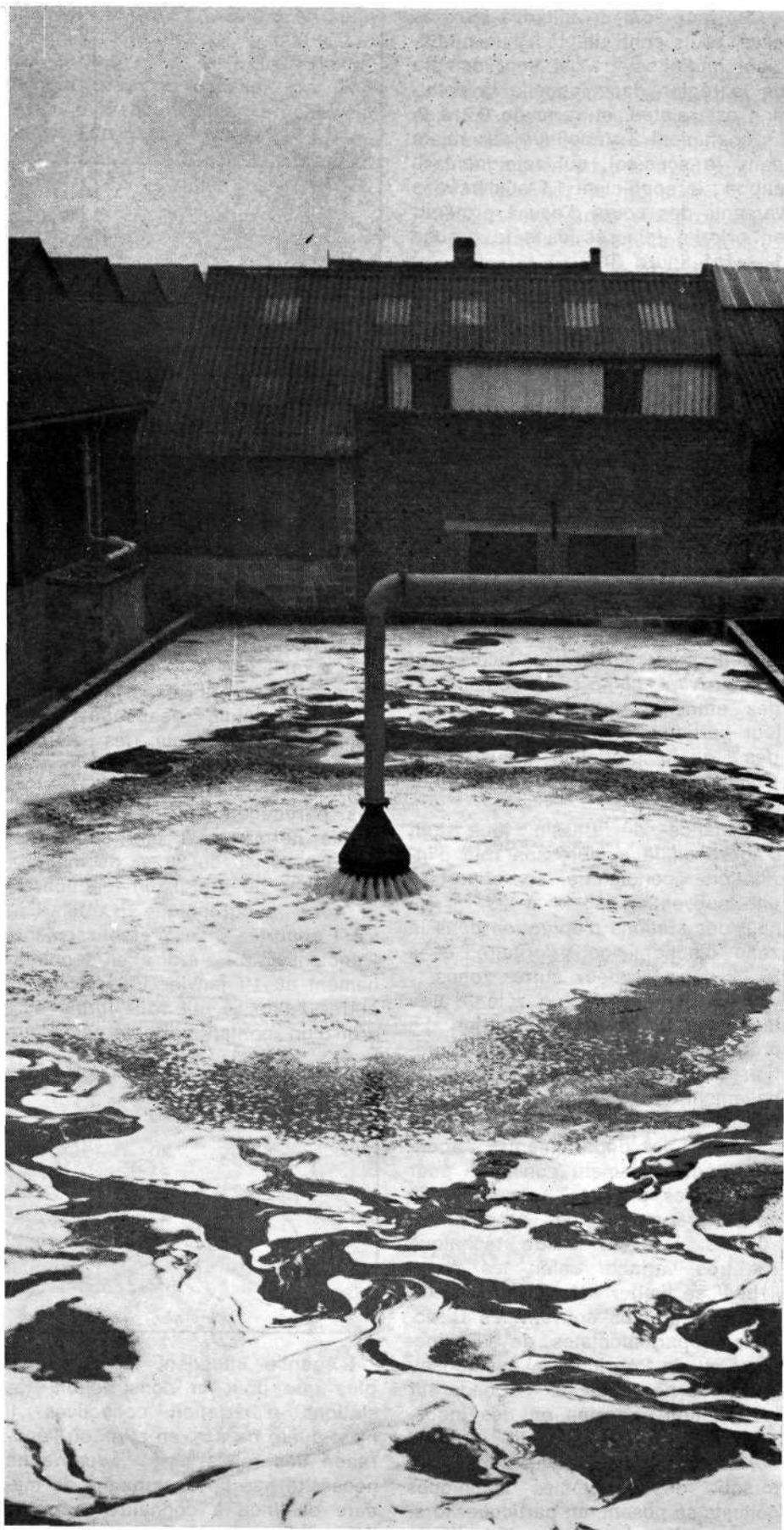
■ Cartonnerie de Wardrecques : bassin de décantation.
