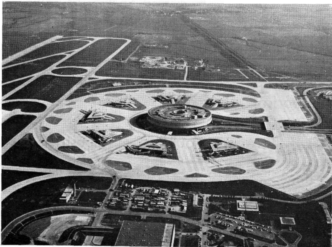
Vue aérienne de l'aérogare passagers n° 1, de ses satellites et des aires de circulation et stationnement des avions.
