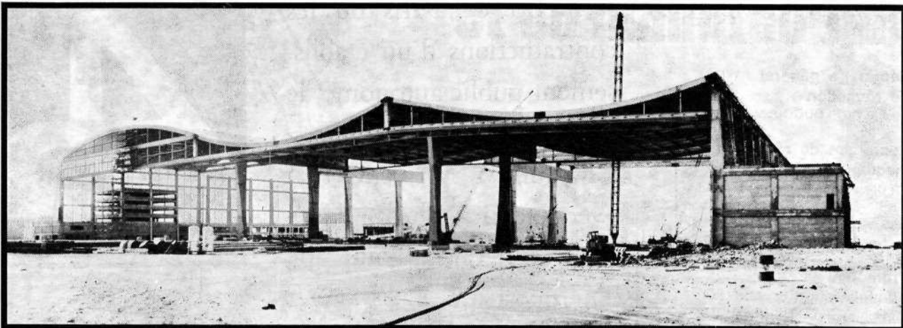
Centre de maintenance (vue du chantier en septembre 1973)
