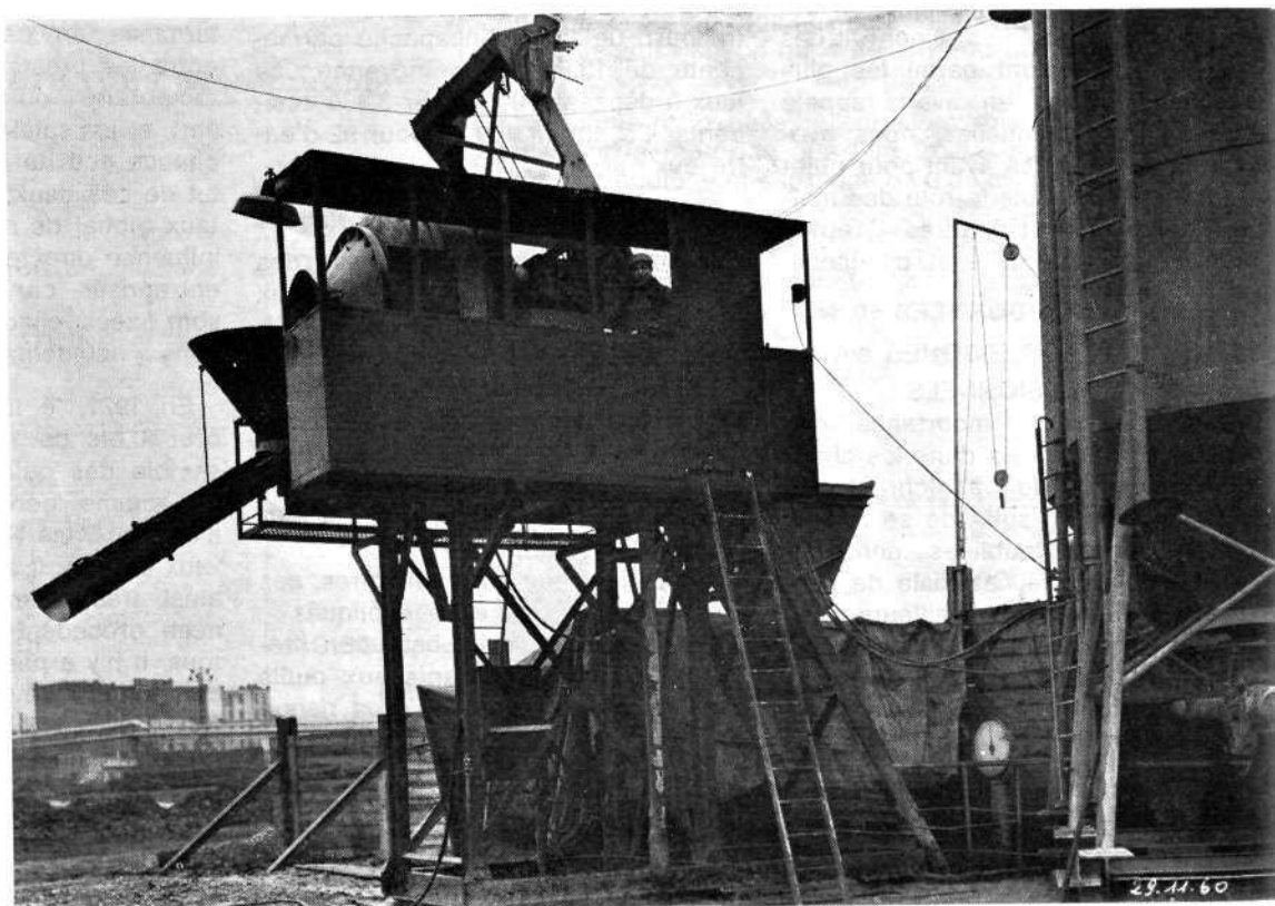
Centrale de bétonnage. On remarque la protection de la fosse de skip, l'abri pour le conducteur de la bétonnière et l'éclairage satisfaisant de l'installation.
