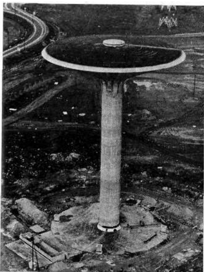
Réservoir de l'Aéroport de Roissy en France
