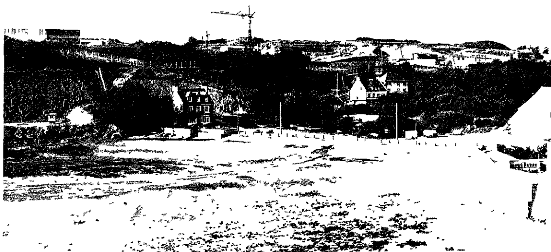
Vue générale — Construction du C.O.B.
