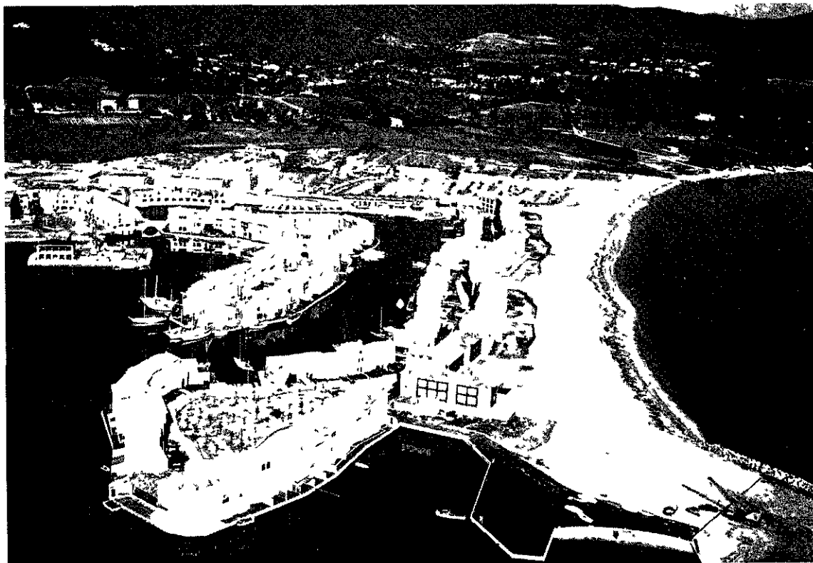
Port de « PORT-GRIMAUD » Construction de la première phase
