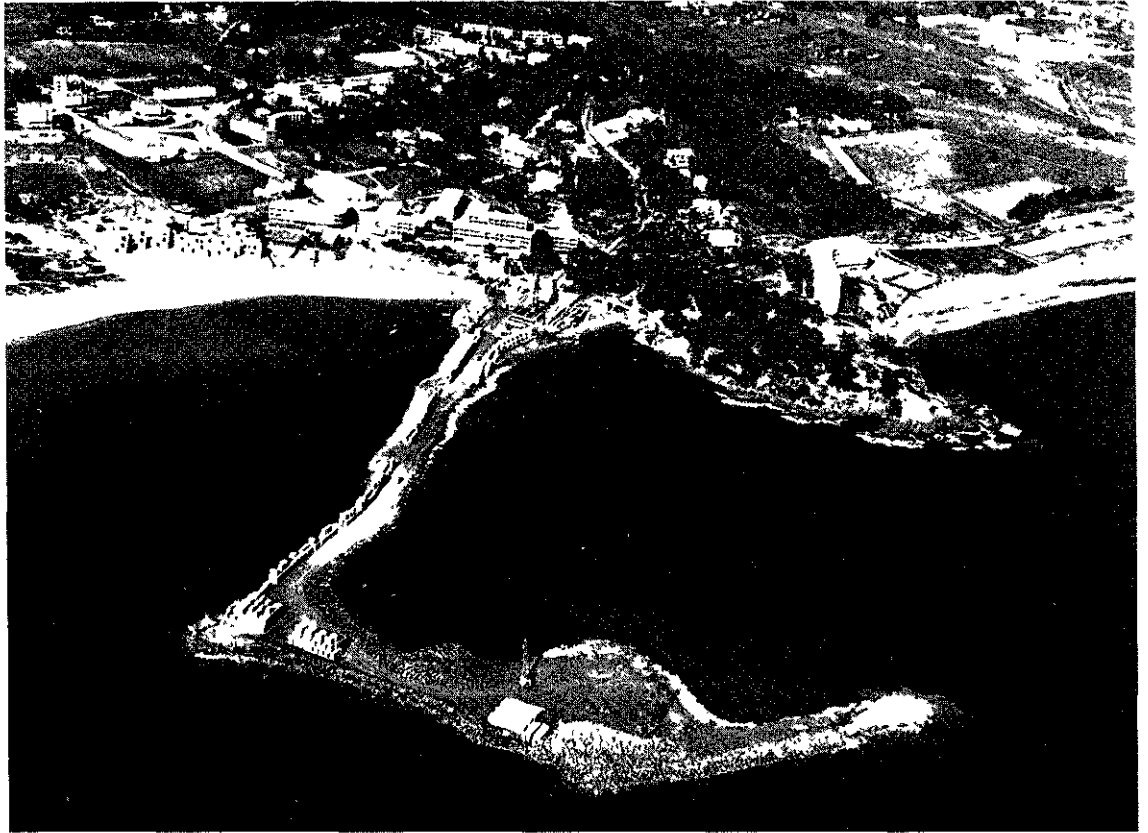
Port de BORMES en cours de travaux
