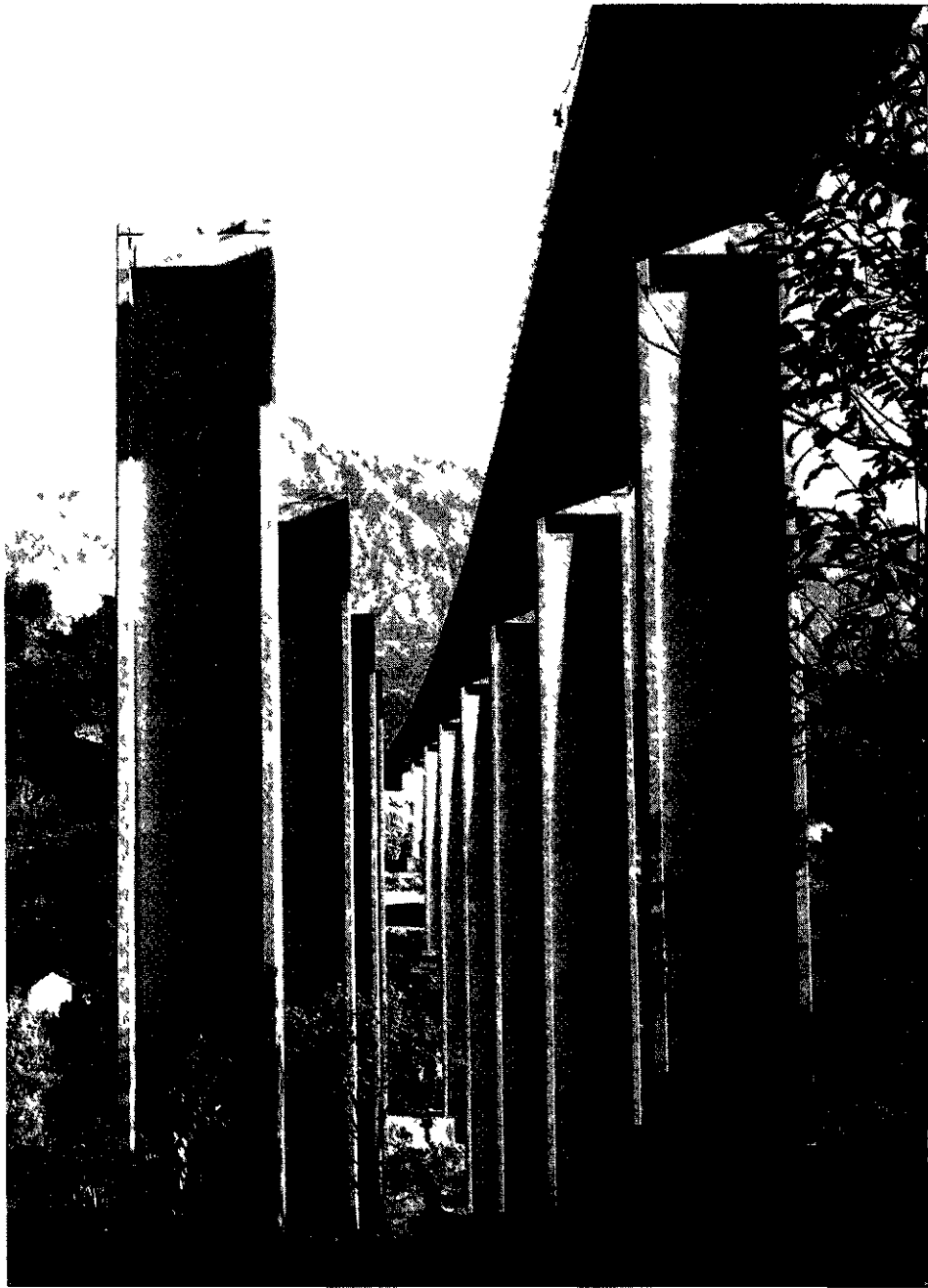
Viaduc du PESLAIRE - Voie Sud
