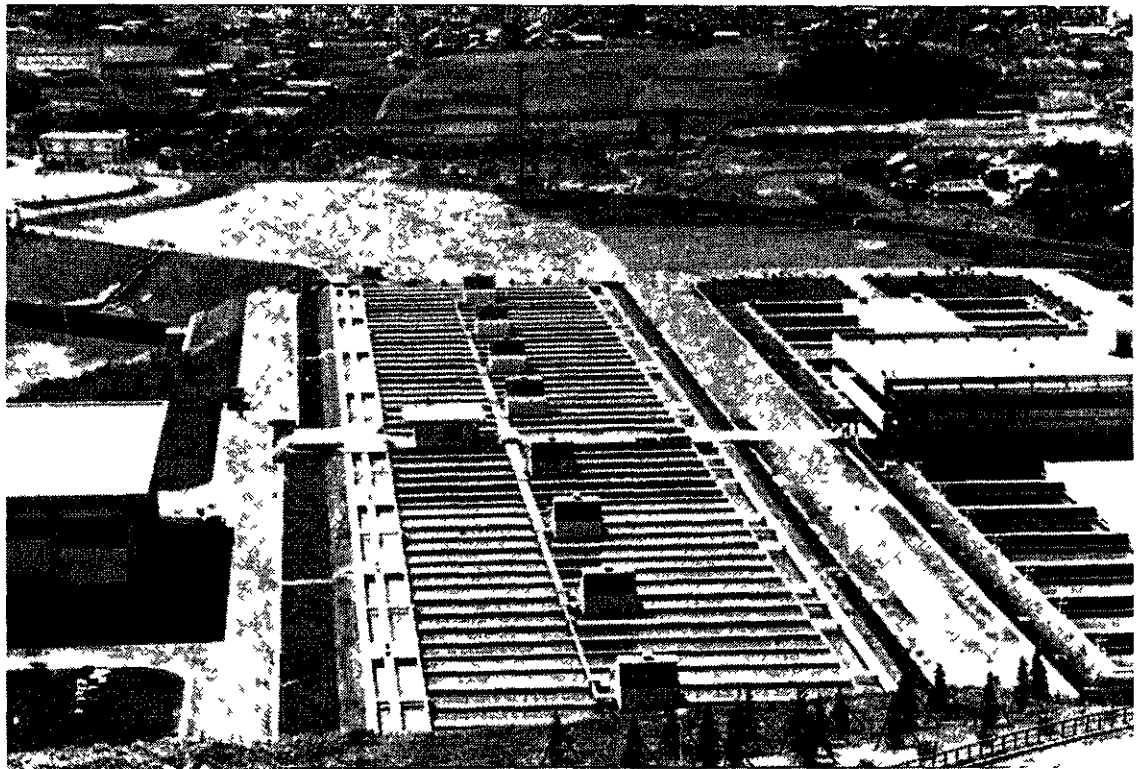
Usine de traitement de Yokohama (500 000 m 3 /jour)
