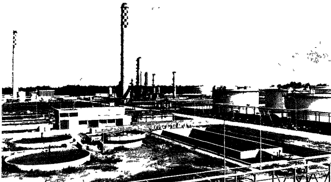
Station d'épuration de Collombey (Suisse)
