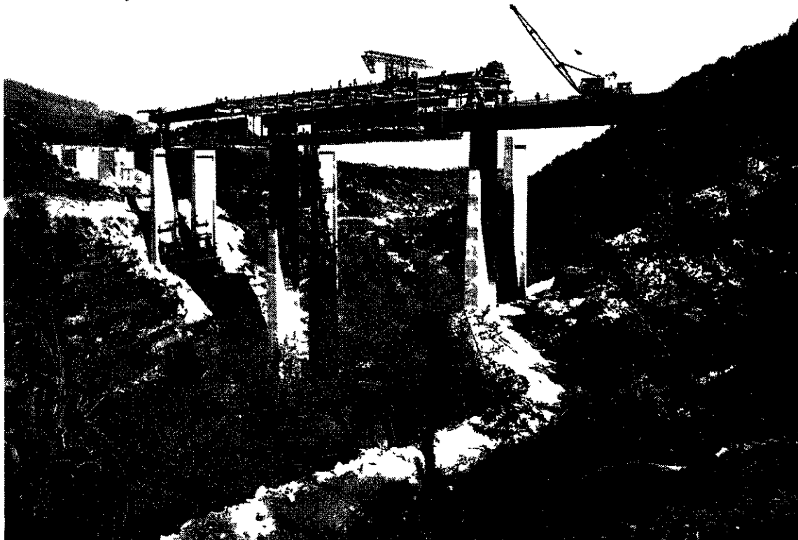
Photo 8. — Cintre sur le viaduc du Gorbio
