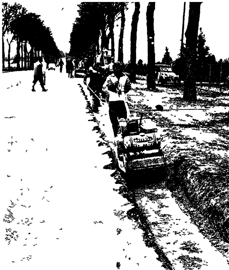
Construction de l'épaulement (phase de compactage)
