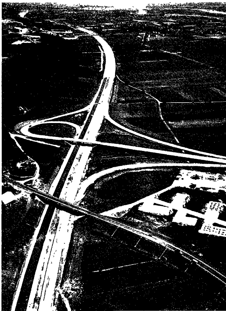
Echangeur de Mâcon-Nord et plateforme vers le Nord
