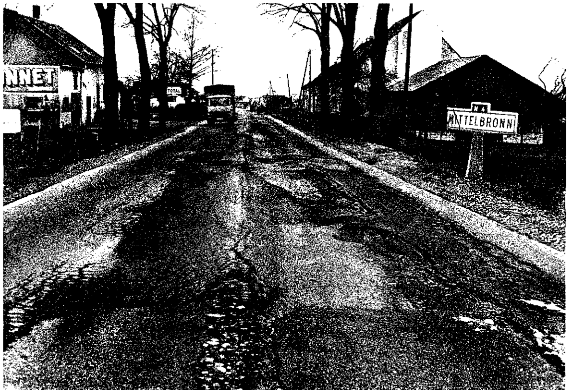
Exemple d'état d'une chaussée dont le renforcement devient très urgent. A remarquer le pincement des couches de chaussées sur chaque voie de la chaussée
