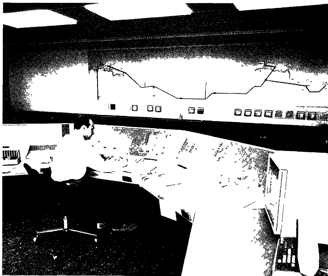
Pipeline R V R. Ruhr-Ludwigshafen Salle de dispatching
