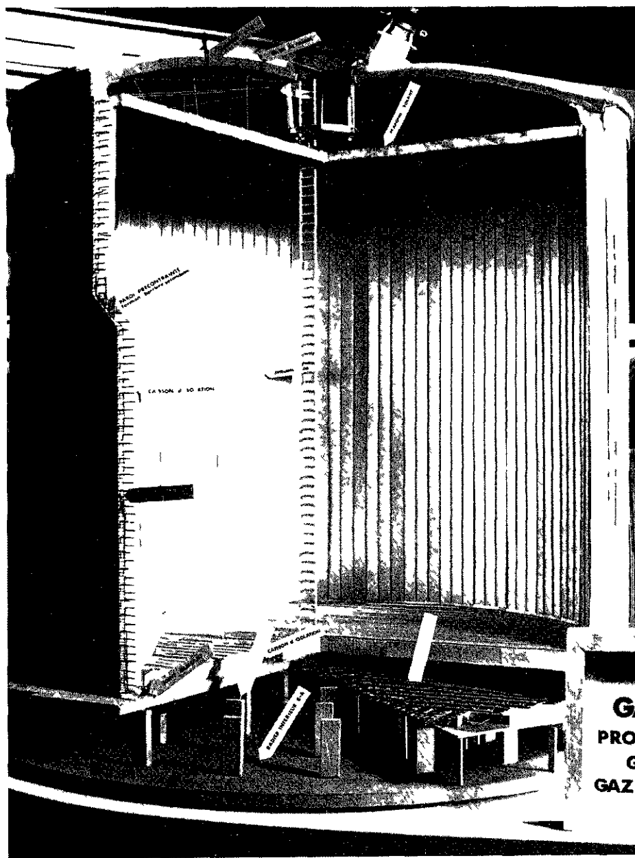
Figure 3 — Maquette de reservoir aerien en beton precontraint Photo Fabrice Naqotte
