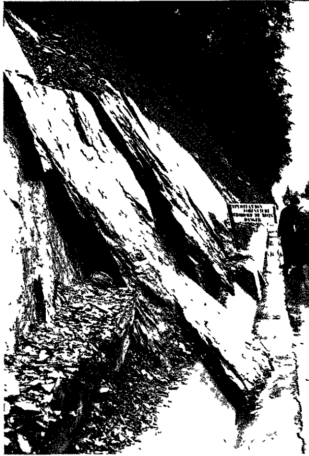
Fig. 1. — Glissement de talus dans le rocher stratifié
