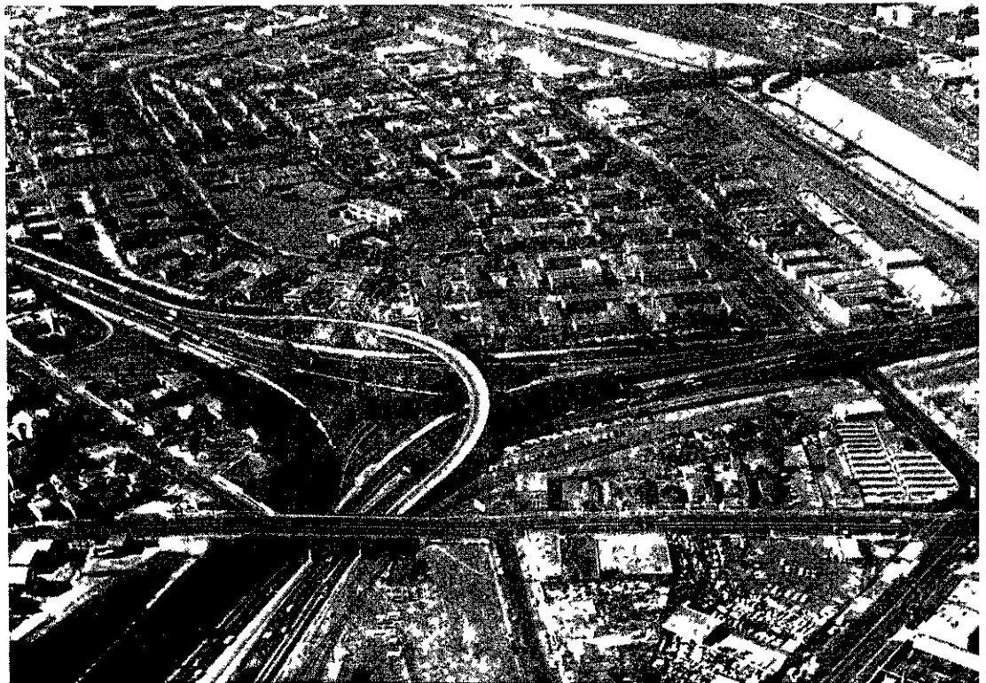
LOS ANGELES : L'échangeur a d'abord attiré la petite usine en bas à droite, puis la Cité ouvrière et un shopping-center.
