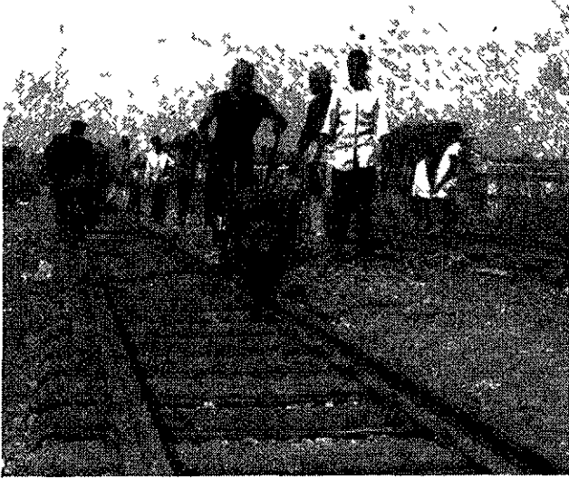
Chantier de substitution de voie
