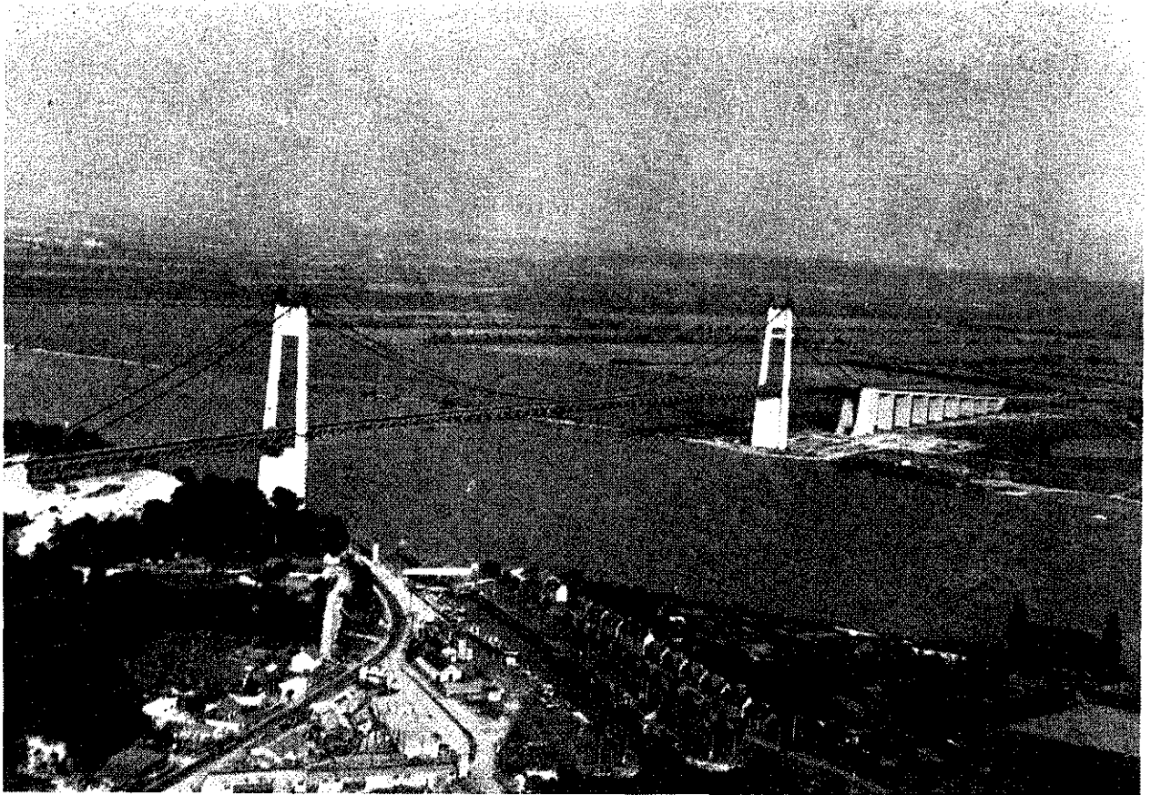
Le Pont de Tancarville. — Vue aérienne sur l'ensemble de l'ouvrage
