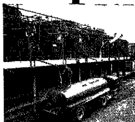
Deversement du goudron dans un camion citerne à l'Usine du Gaz de France
