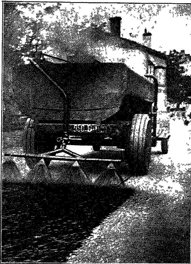
Répandage de GOUDRON-BITUME.
