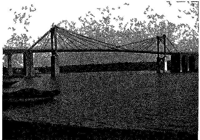
Pont de Lezardrieux, sur le Trieux (C-du-N)
