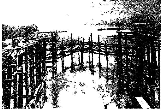
Echafaudage du Caisson n° 3. Vue de l'aval, Rhône ou très basses eaux. (25 octobre 1938).
