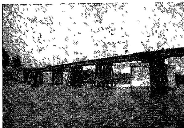
PONT DE SEVEUX
