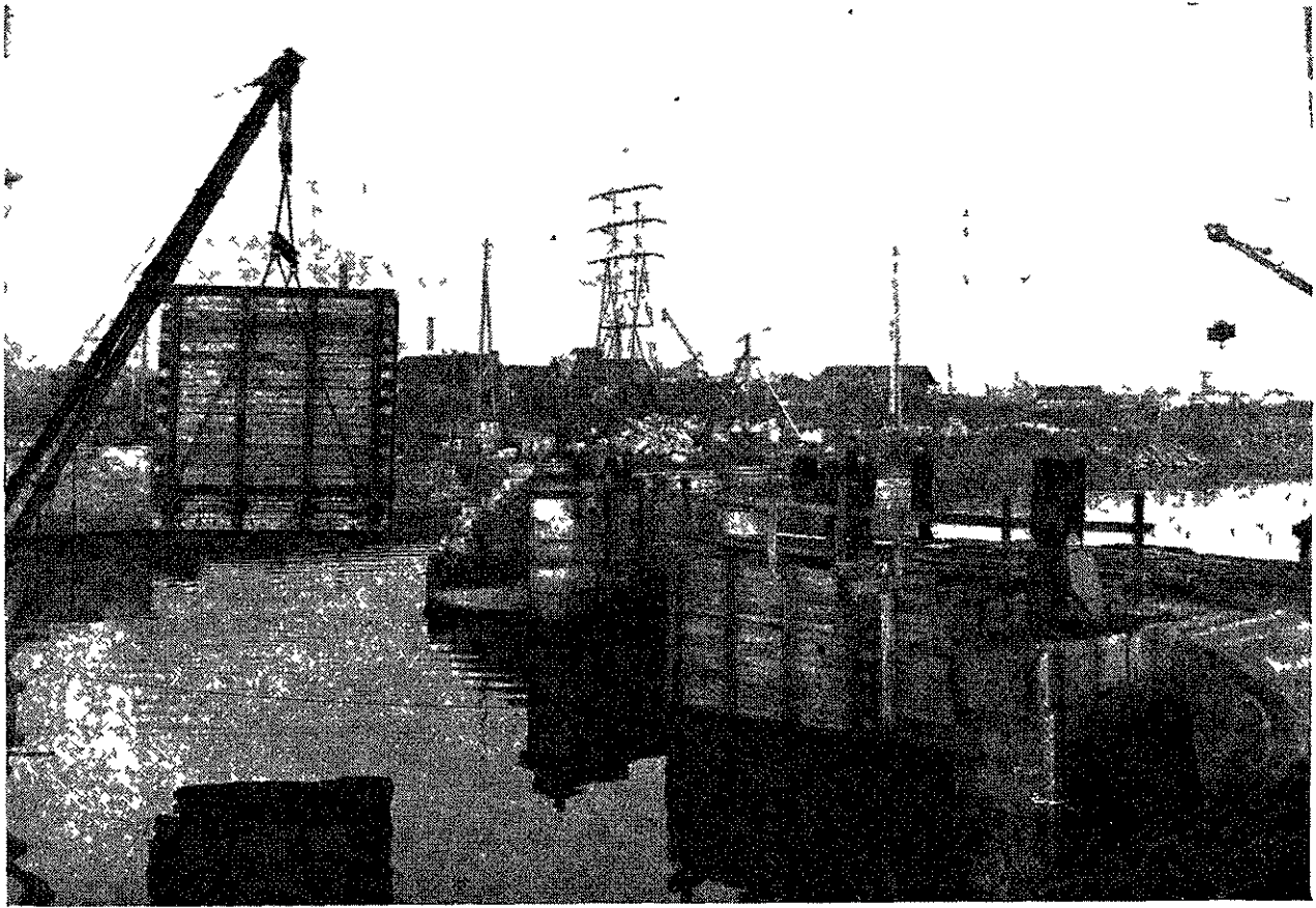
RECONSTRUCTION DE LA MOITIÉ DROITE DE L'OUVRAGE (1 er BATARDEAU) . MISE EN PLACE D'UNE CAISSE.
