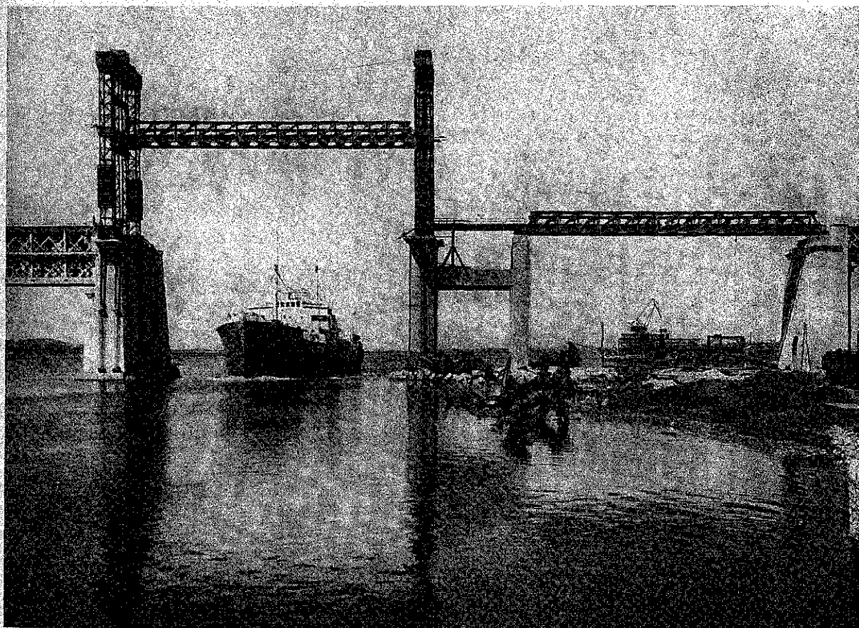
LE VIADUC DE CARONTE (Ligne de Miramas à l'Estaque) : remplacement du pont tournant détruit par une travée levante.
