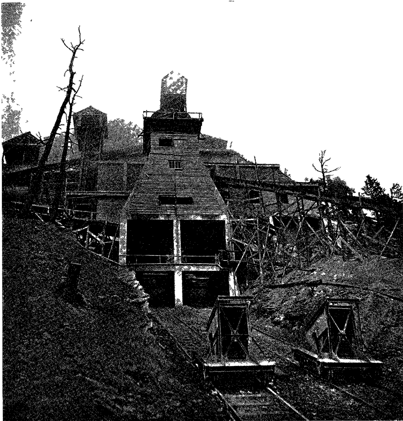
BARRAGE D AUSSOIS Transport du béton par skip
