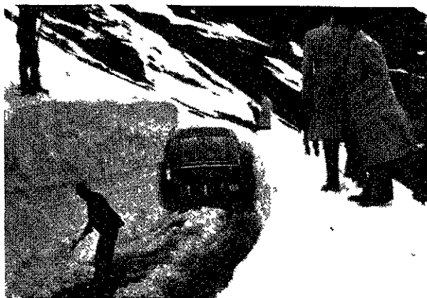
L'ouverture d'un grand col (Col de Sousten, Suisse) effectuée le 28 juin 1951 par les Services Suisses à l'occasion d'une tournée d'Ingénieurs français. (L'autocar donne l'échelle)
