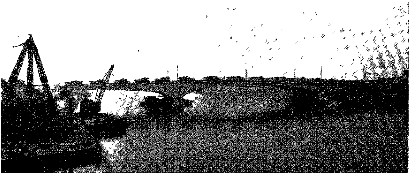
Pont Jacques BOULLOCHE : Essais statiques (2.400 tonnes. 20 octobre 1953)
