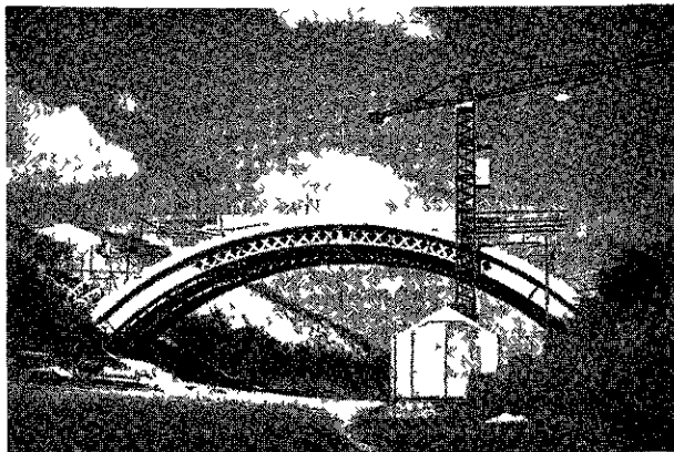
Parc de Parilly : Pont Ouest, cintre en place et courbe du béton (photo n° 2)
