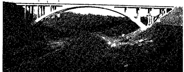
Parc de Parilly : Pont sur la tranchée Ouest du Boulevard de Ceinture (photo n° 3)
