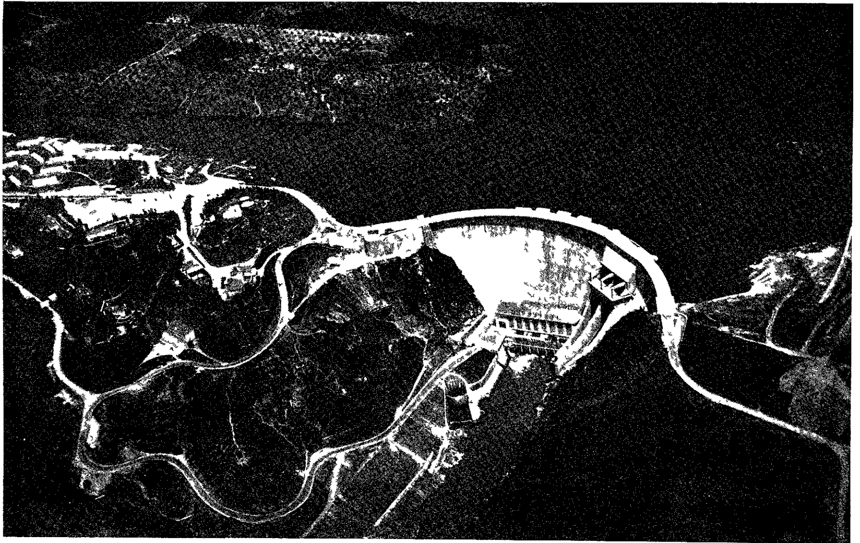
Une réalisation de M. André COYNE Le Barrage de Castelo do Bode (Hidro Electricita do Zezere, au Portugal)
