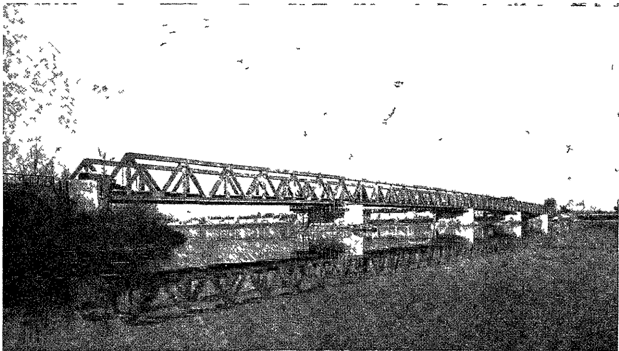
LE NOUVEAU PONT DE SAINT-MATHURIN SUR LA LOIRE (Mai 1954)
