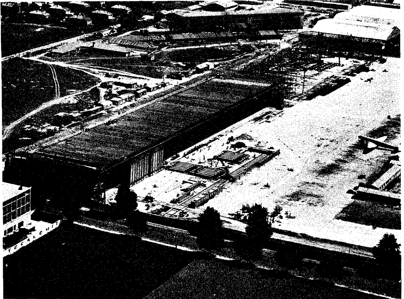
Fig. 1. — Vue aérienne partie Ouest de la zone industrielle Nord de l'Aéroport d'Orly (Prise le 20-7-1954). Le hangar N1 est couvert, les portes sont en cours de montage. L'ossature métallique du hangar N2 est en cours de construction.
