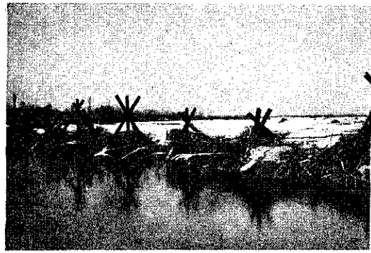
Fig 8 - Aspect caractéristique des premiers dépôts à l'intérieur des tétraèdres (25-1-1953) (Partie amont de la digue)
