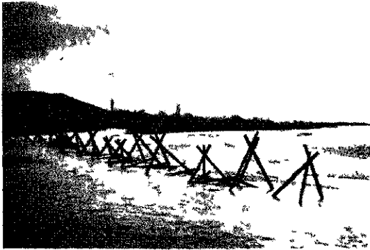
Fig 2 - Extrémité amont de la digue immédiatement après la pose (6 11 1952) Débit dans la rivière 2\text{m}^3/\text{sec}
