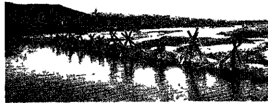
Fig 3 - Même vue que la fig 2 (4 1 1953) Débit 2\text{m}^3/\text{sec}
