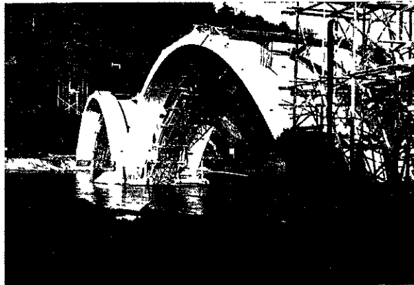
12. — Les arcs sont coulés (sauf les naissances). Les 2 cintres ont été ripés entre les arcs en vue de leur démontage. A droite, les échafaudages pour construction du tablier.
