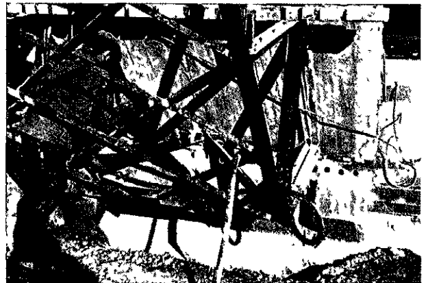
9. — Décintrement de l'arc. — Exécution au fleuret de trous en vue de la destruction du béton ou appui.
