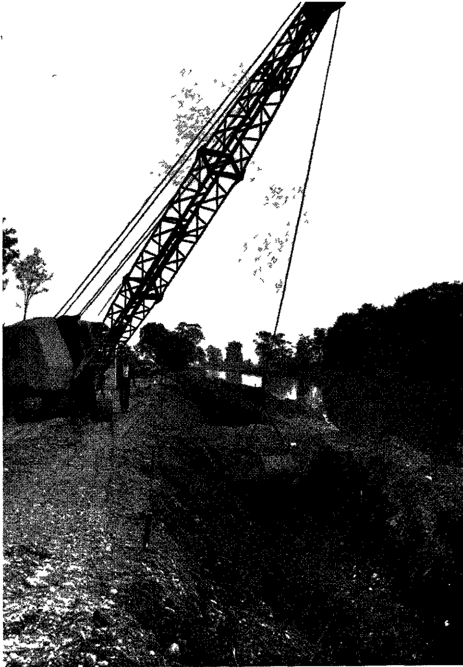
Cliche 1 — Préparation du nouveau talus
