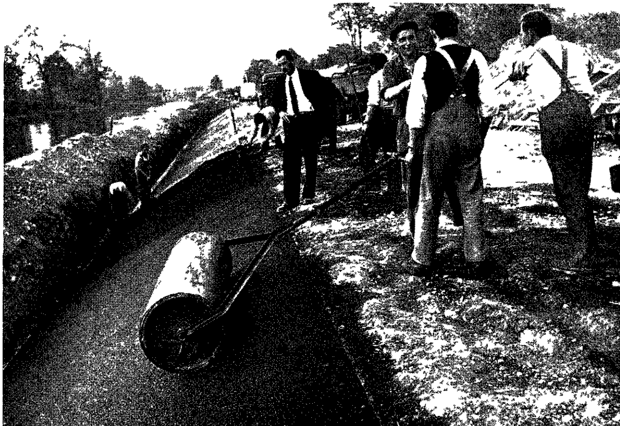
Cliché 3. — Cylindrage du revêtement (le cylindre est manœuvré à l'aide d'un treuil monté sur un Dodge 4×4. On aperçoit le câble à droite de la photo).
