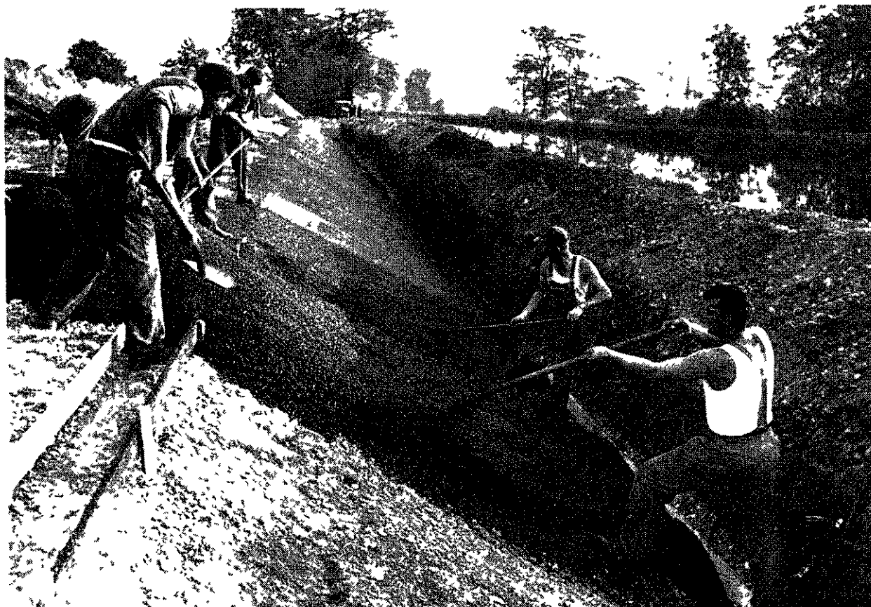
Cliché 2. — Mise en œuvre d'enrobés denses
