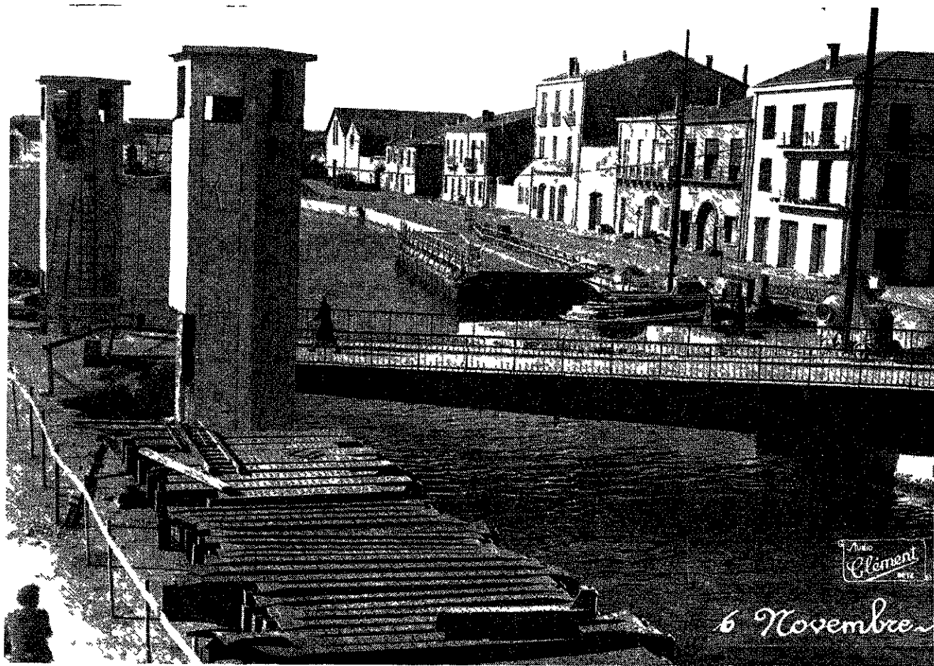
Fig. 1 — Ancien pont tournant à une voie — Tours Sud en cours de construction Au second plan : ponton mobile devant servir à assurer provisoirement la circulation.
