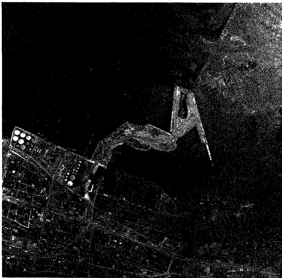
Travaux d'aménagement du port de KOBÉ.
